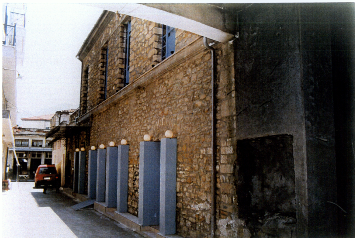
Φωτ. 1: Πρόσοψη του κτιρίου του Κοινωνικού Φορέα.
