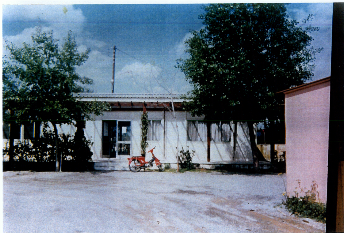
Φωτ. 2: Πρόσοψη κτιρίου Β΄ Κ.Α.Π.Η. Καλαμάτας.
