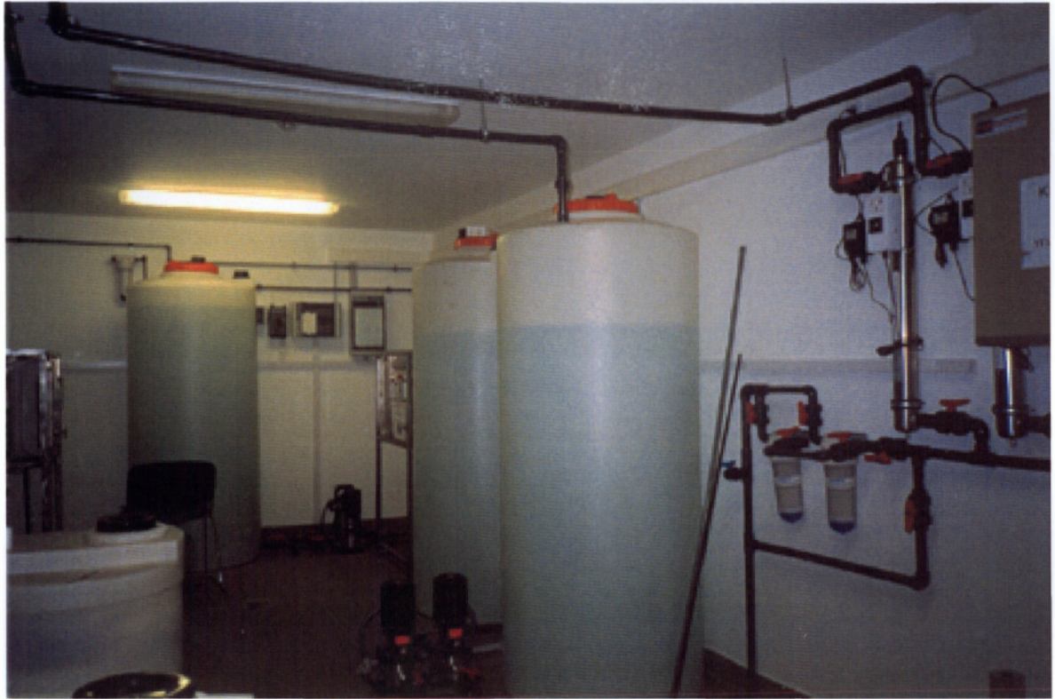
Φωτογραφία 1: ο χώρος αποστείρωσης του νερού - απιονιστής
