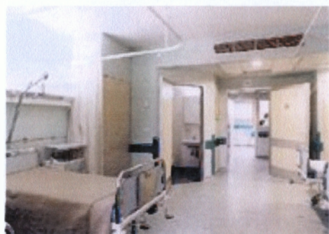
ΚΛΙΝΕΣ ΑΝΑΤΟΛΙΚΟΥ ΚΤΙΡΙΟΥ
