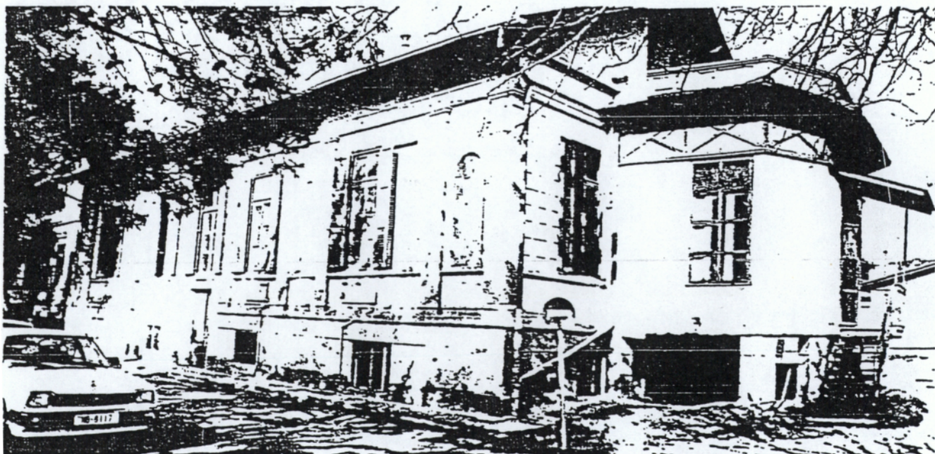
ΚΟΝΙΤΣΗΣ 13. Απόληξη πτέρυγας στο κεντρικό κτίριο.
