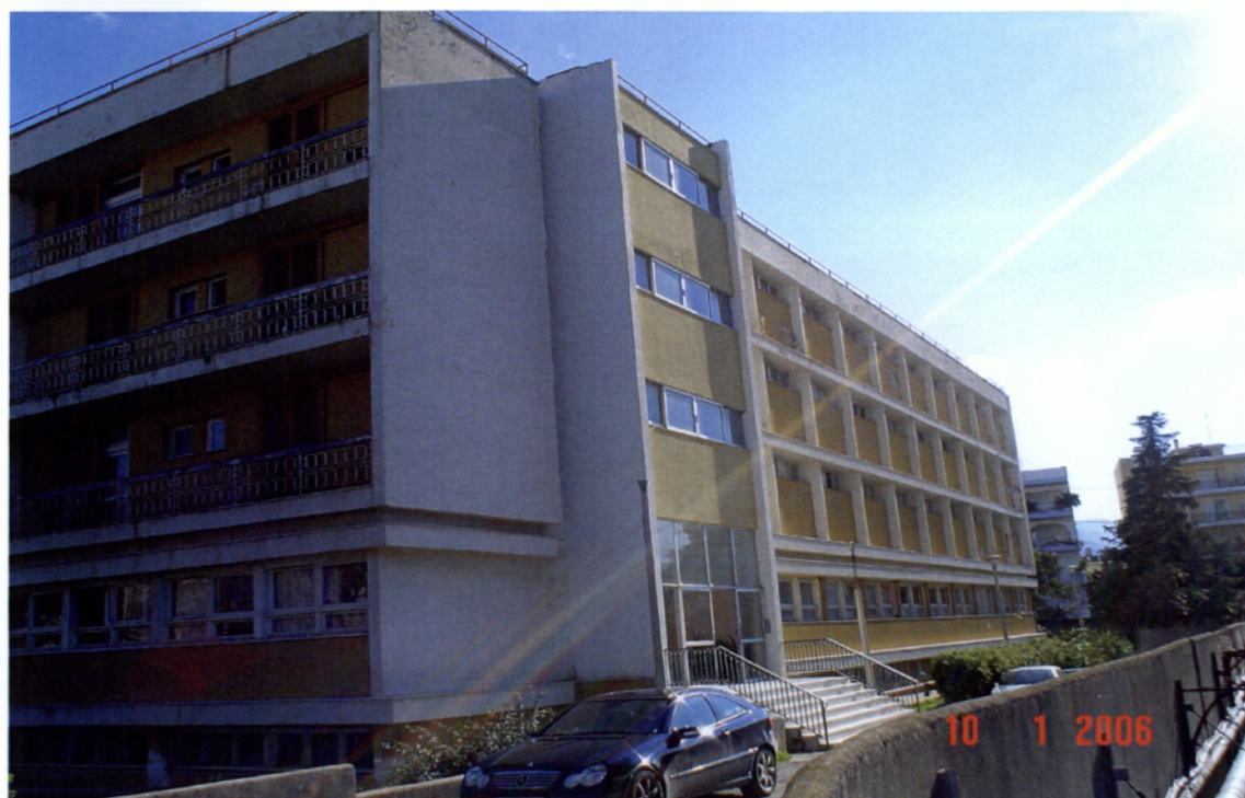
Εικόνα 10: Το κτίριο της Σχολής Αδελφών Νοσοκόμων του Γ. Ν. Π. «Ο Αγ. Ανδρέας» όπου στεγάζεται το Τ. Ε. Ε. Α΄ Κύκλου σπουδών
