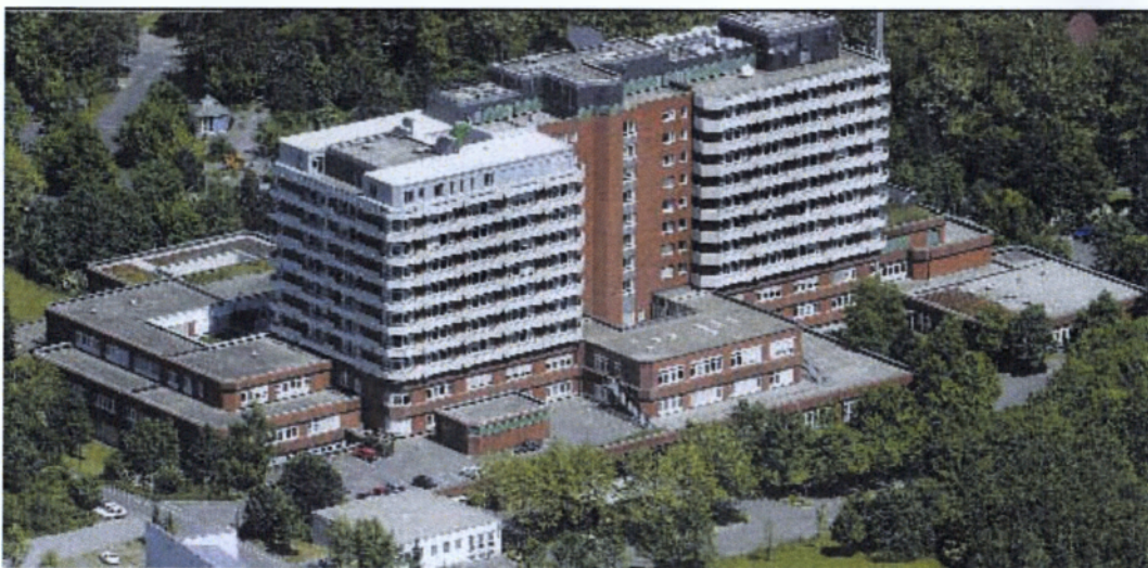
Εικόνα 4.3: Άποψη του νοσοκομείου Knappschaft και των περιμετρικών του χώρων, Γερμανία
