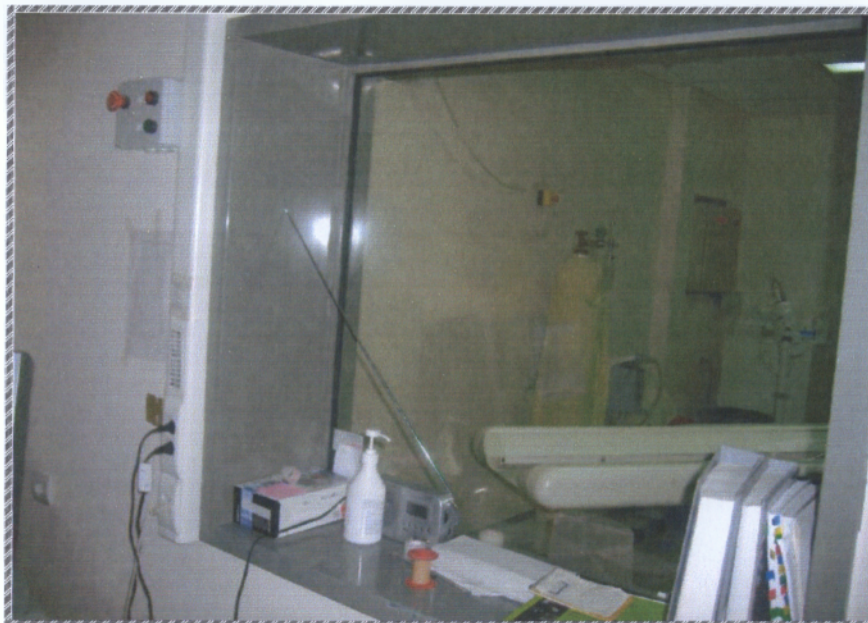
Εικόνα 2.4/α : Παράθυρο παρατήρησης εμπλουτισμένο με μολυβδύαλο
