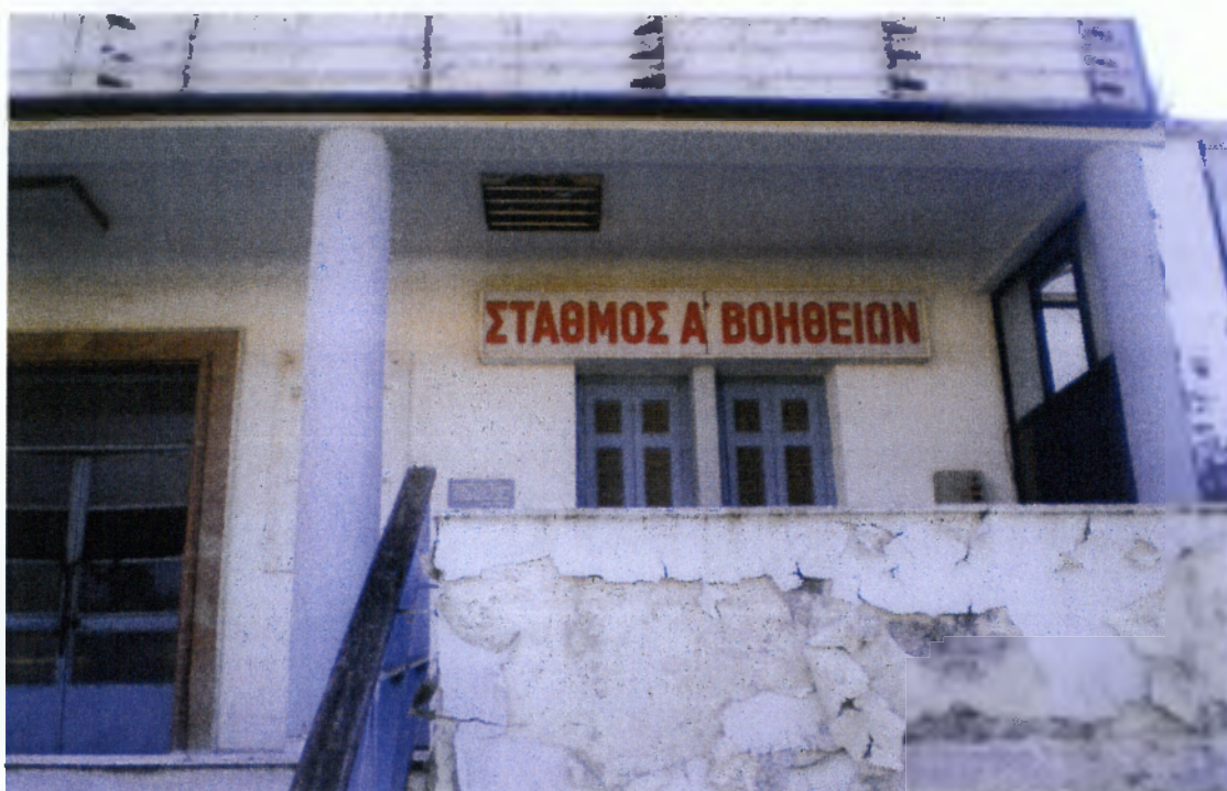
Η κεντρική είσοδος του “Παλαιού Νοσοκομείου” Καλαμάτας, λίγα χρόνια μετά από τη μεταστέγασή του στο νέο κτιριακό συγκρότημα, ίσως είναι μια από τις πιο χαρακτηριστικές εικόνες που μαρτυρούν την αδράνεια των φορέων της πόλης (Πηγή Ίδιες φωτογραφικές λήψεις)
