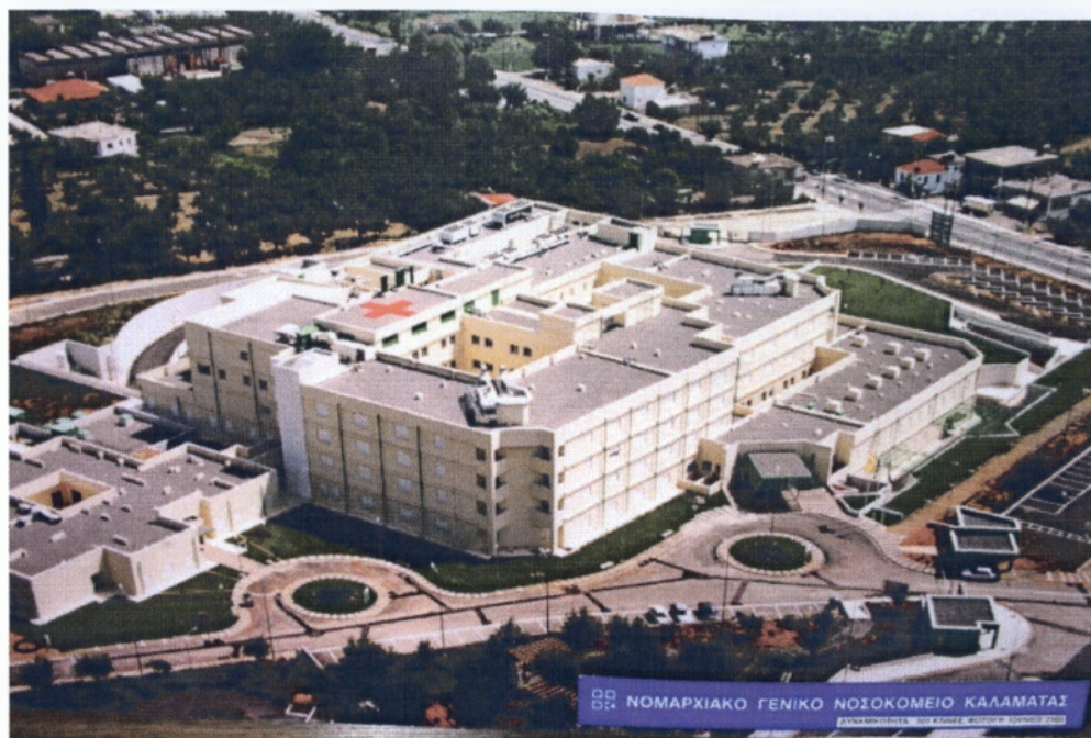
Εικόνα 2.1 Γενικό Νοσοκομείο Καλαμάτας
