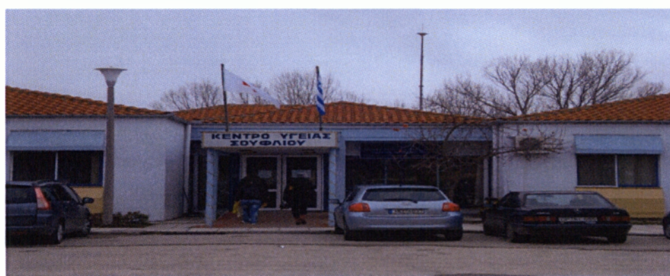
Εικόνα 3. Εξωτερική άποψη του Κέντρου Υγείας Σουφλίου
