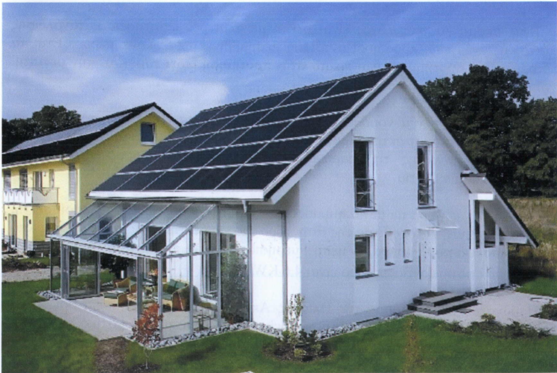
Εικόνα 2: Φωτοβολταϊκό σύστημα σε γεωργική έκταση και σε στέγη (Solar Systems)
