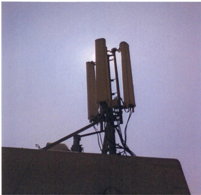
Σχήμα 1. Σταθμός Βάσης GSM
