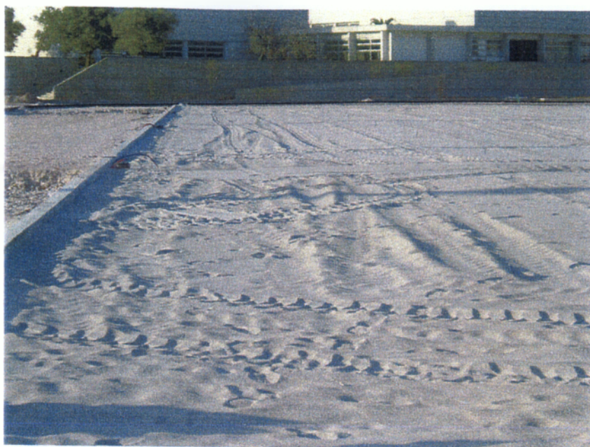
Εικόνα 4. Διάστρωση των γηπέδων με ψηφίδα ( 27/01/2004 )
