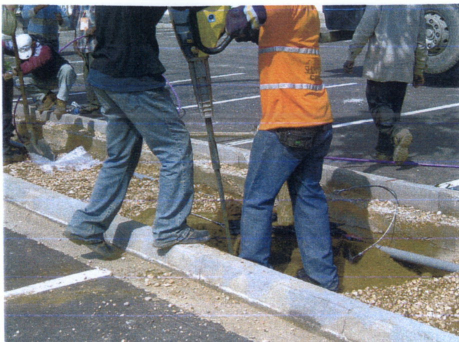
Εικόνα 5. Ολοκλήρωση της στήριξης 17 Μουριών στο Δυτικό parking ( 06/03/2004 ).
