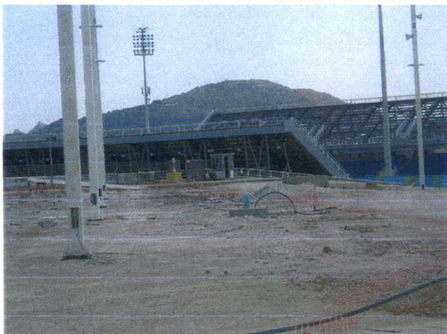
Εικόνα 7. Χωματουργικές εργασίες για προετοιμασία φύτευσης στην περιοχή του κολυμβητηρίου ( 21/06/2004 ).
