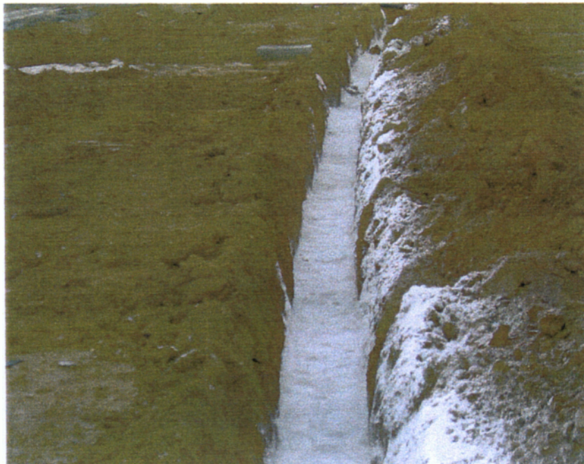
Εικόνα 2. επικάλυψη των σωλήνων με άμμο και επίχωση των τάφρων ( 10 – 11/12/2003 ).
