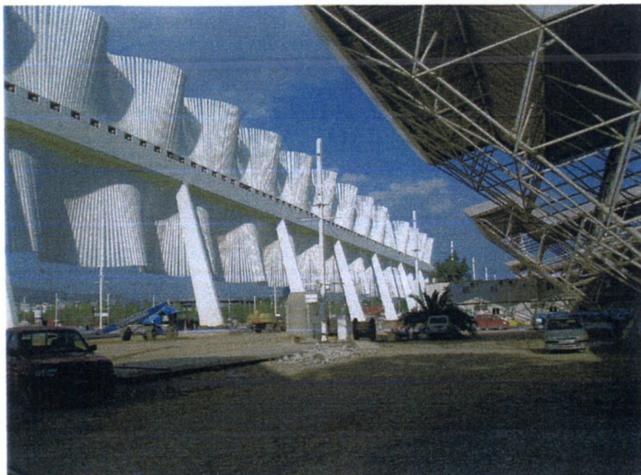
Εικόνα 1. Χωματουργικές εργασίες στο Τείχος των Εθνών για υποδοχή φύτευσης ( 02/07/2004 ).
