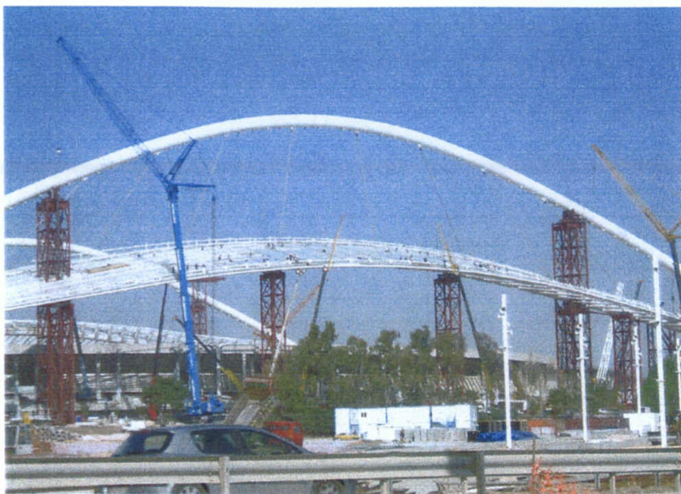
Εικόνα 3. Στέγαστρο του Ολυμπιακού Σταδίου σε στήριξη πυλώνων .
