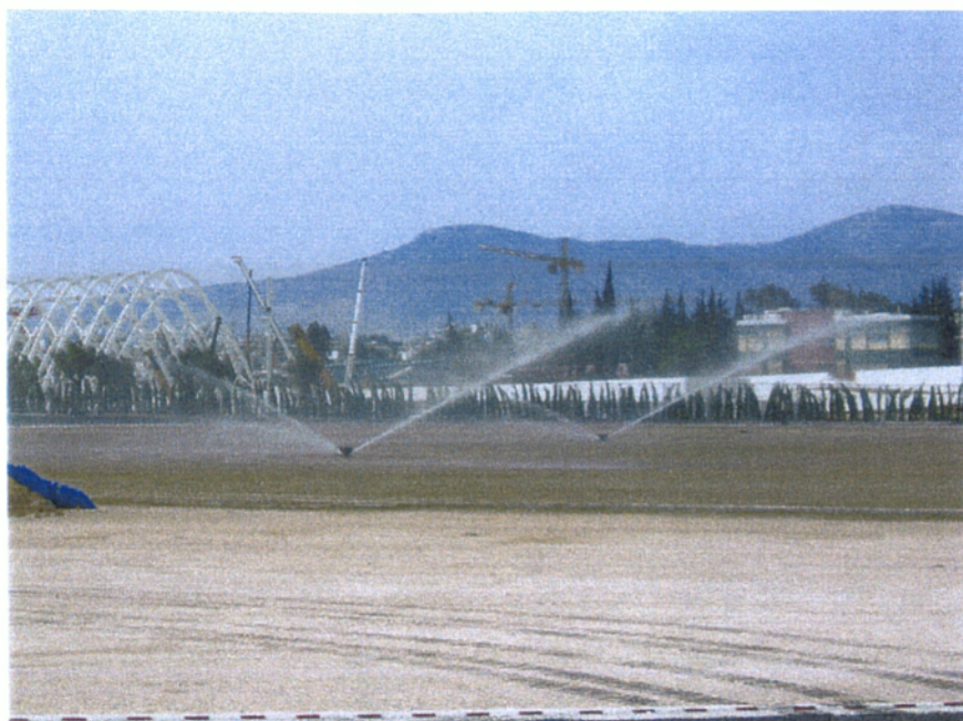
Εικόνα 6. Αρδευτικό σύστημα pop – up για άρδευση γηπέδων .
