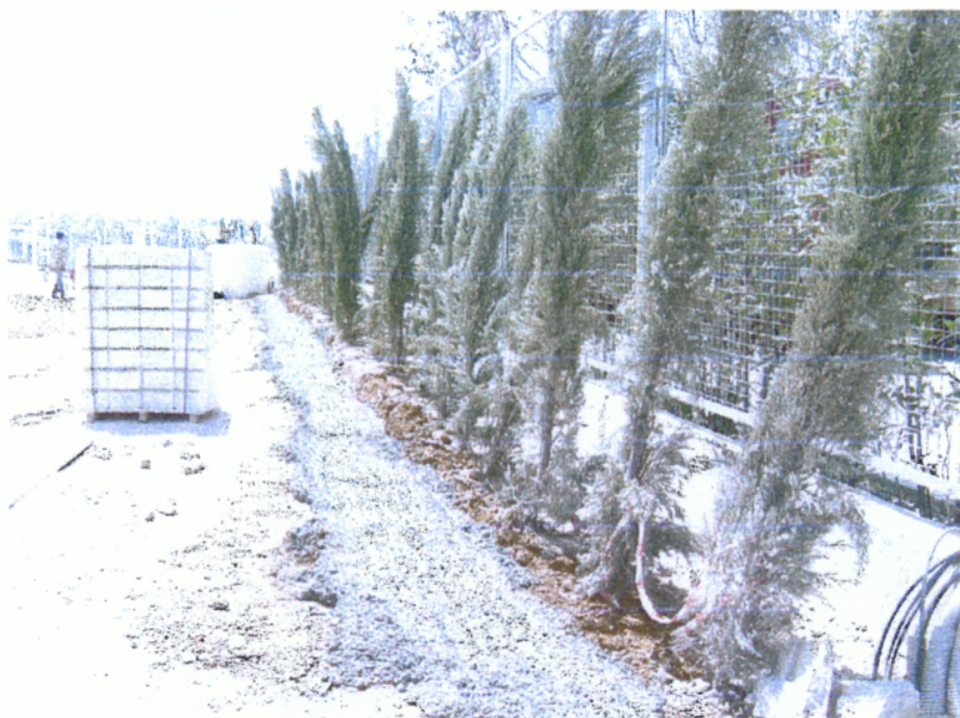
Εικόνα 17. Τοποθέτηση 60 φυτοφραχτών στις 27/03/2004.
