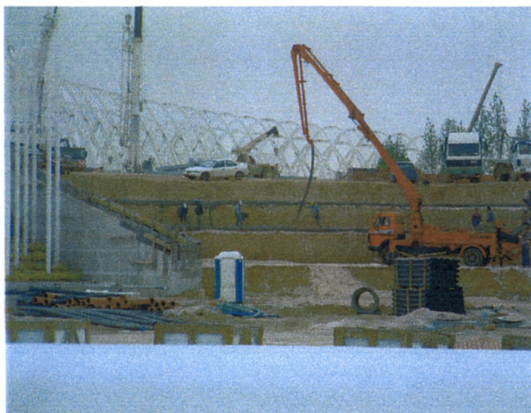
Εικόνα1. Περιοχή πρανούς σημαιών.
