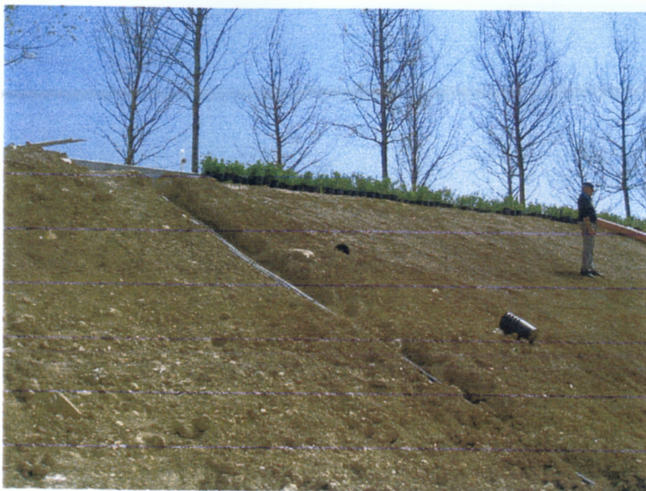
Εικόνα 10. Στο επάνω μέρος του πρανούς των Τριανταφυλλιών διακρίνεται η τοποθέτηση φυτοφραχτών που έγινε στις 04/04/2004.
