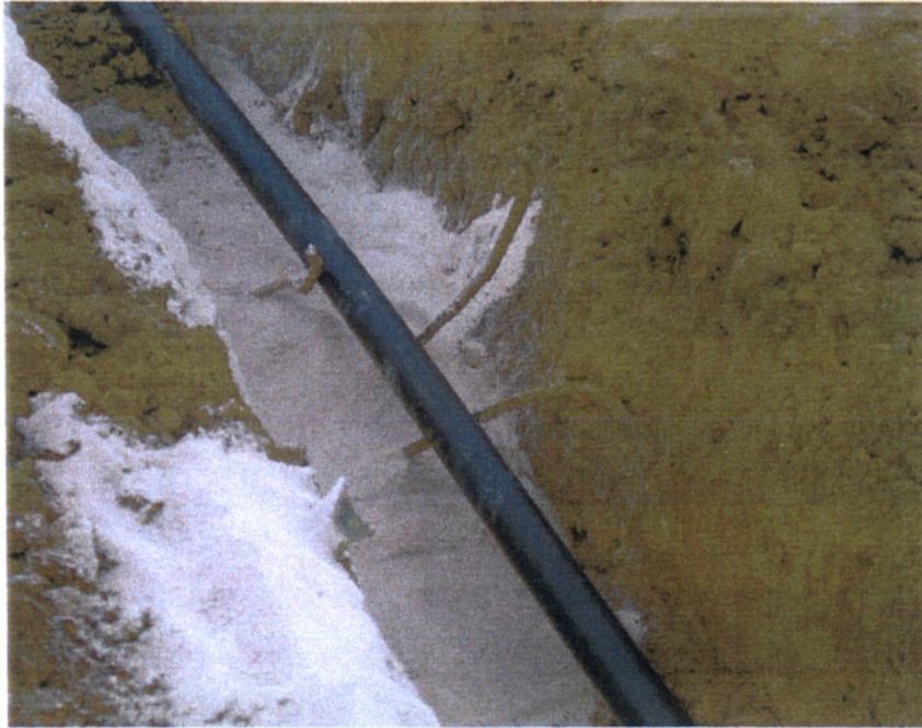
Εικόνα 1. Διάνοιξη τάφρων συνολικού μήκους 330μ και βάθους 40 εκ για υποδοχή σωλήνων άρδευσης ( 8 – 9/12/2003 )
