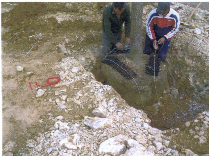
Εικόνα 5. Έγινε τοποθέτηση 20 συστημάτων στήριξης Platisus στους λάκκους της 2 ης και 3 ης βεντάλιας στην Δυτική Αγορά ( 16/12/2003 )
