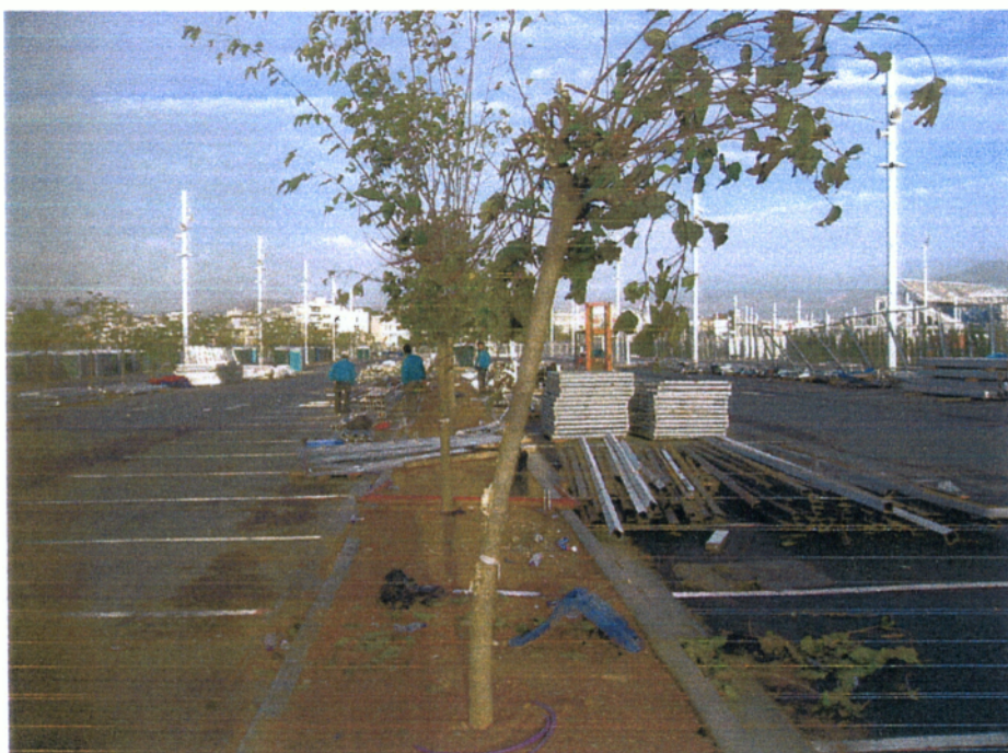
Εικόνα 4. Διάστρωση νησίδων με χώμα στο parking της Σπύρου Λούη στις 19/07/2004.
