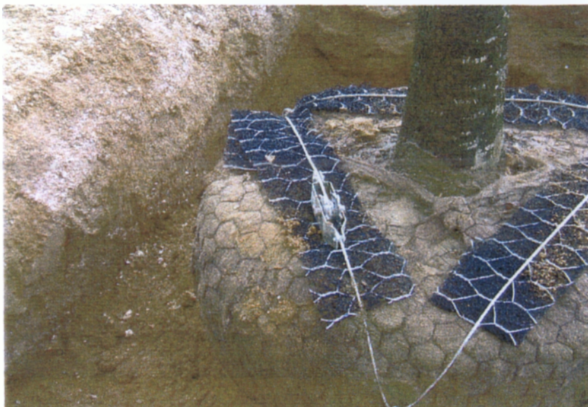
Εικόνα 3. Σφίξιμο καστανιών στα Platipus ( 04/02/2004 ).
