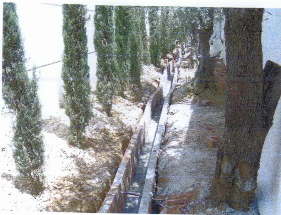
Εικόνα 18. Τοποθέτηση 259 φυτοφραχτών στον ευρύτερο περιβάλλοντα χώρο ( 28/03/2004 ).
