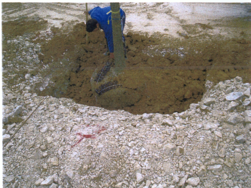
Εικόνα 7. Τοποθέτηση 5 συστημάτων υπόγειας στήριξης στους λάγκους της 2 ης και 3 ης βεντάλιας ( 19/12/2003 ).
