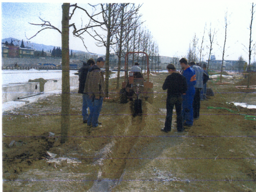
Εικόνα 12. Εκσκαφή 240μ μήκος τάφρου σε 2 η , 3 η και 4 η βεντάλια στις 16/03/2004.
