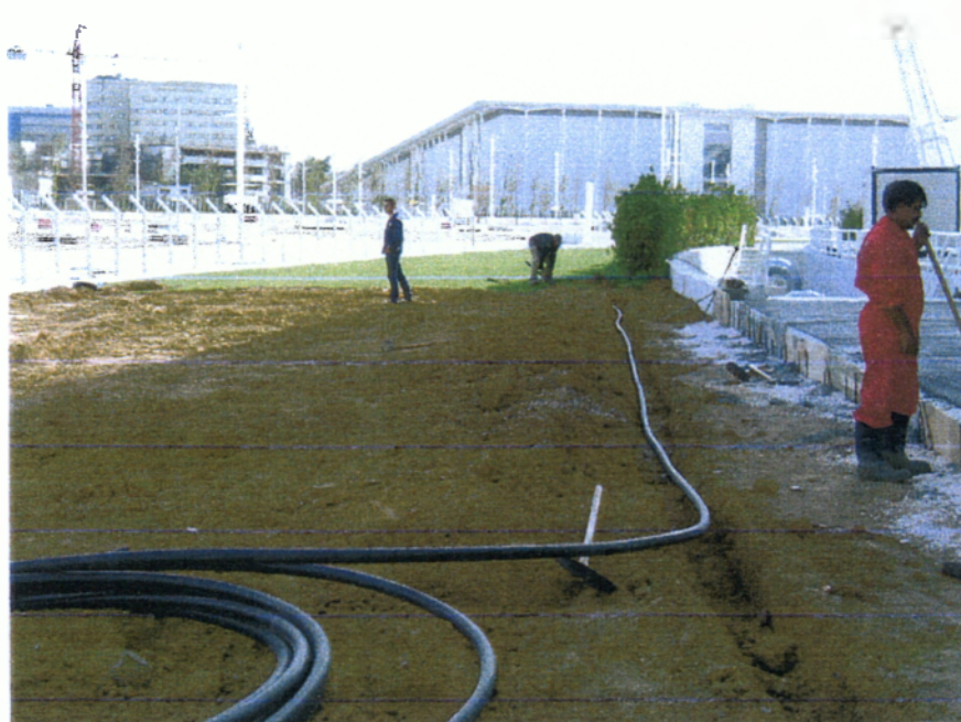
Εικόνα 6.Εγκατάσταση υπόγειου συστήματος άρδευσης στην περιοχή του Άκτωρα , γύρω από το κυρίως στάδιο διεξαγωγής των αγώνων ( 17/06/2004 ) .
