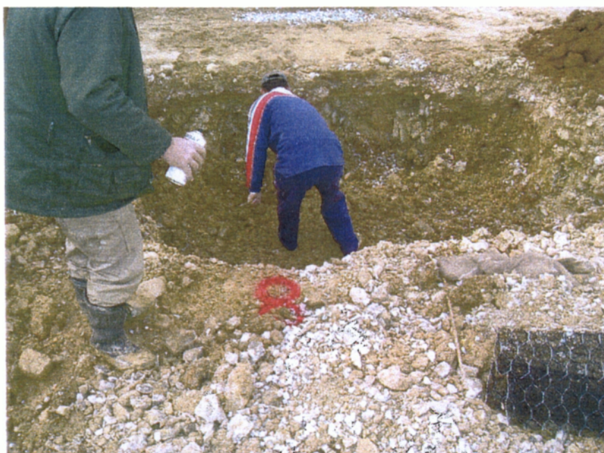
Εικόνα 6. Διάνοιξη 24 λάκκων για τοποθέτηση πλατανιών στην 3 η και 4 η βεντάλια ( 17/12/2003 ) .
