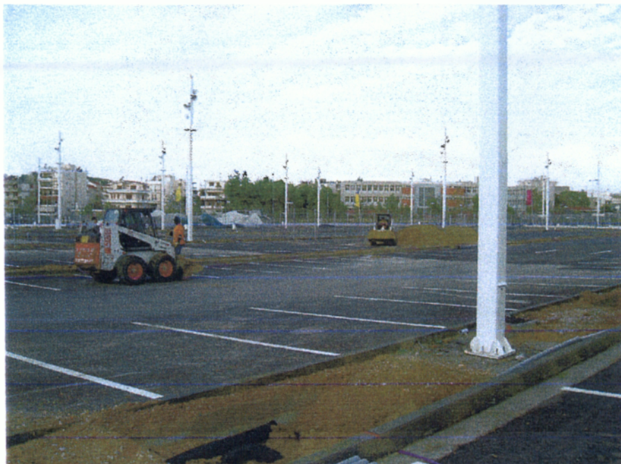
Εικόνα 1. Διάνοιξη 31 λάκκων στο Δυτικό parking για την τοποθέτηση Μουριών ( 02/03/2004 ).
