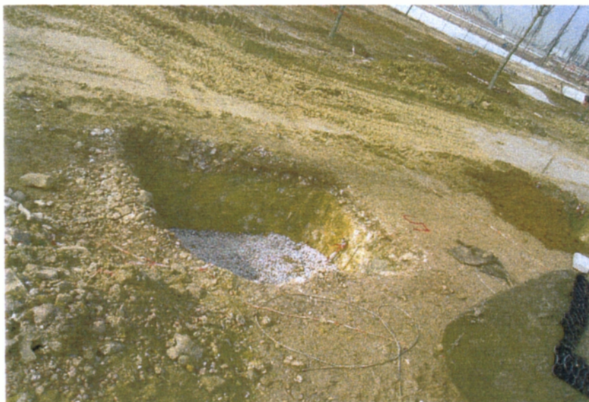
Εικόνα 4. Τοποθέτηση χαλίκιού στους υπό διάνοιξη λάγκους ( 05/02/2005 )
