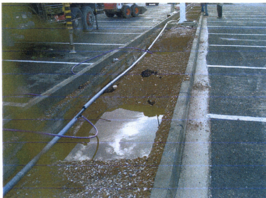
Εικόνα 2. Διανοίχτηκαν 37 λάκκοι στο Δυτικό parking για την τοποθέτηση Μουριών ( 03/03/2004 ).
