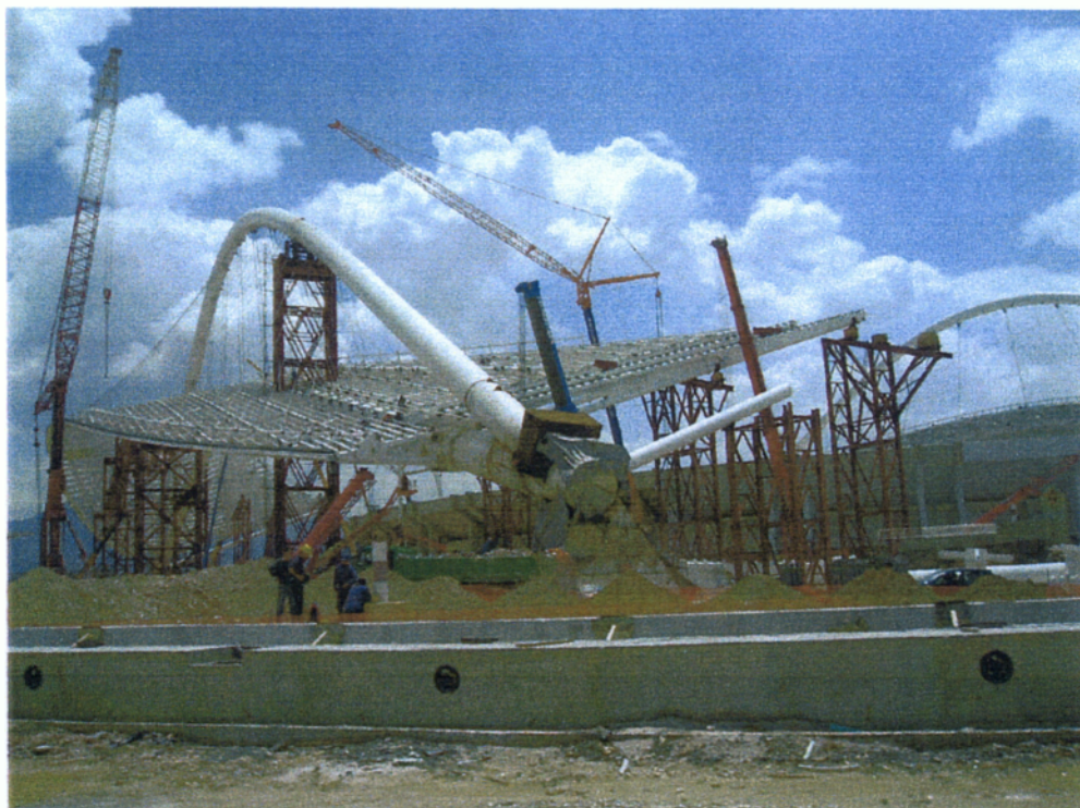
Εικόνα 4. Στέγαστρο του Ολυμπιακού Σταδίου σε δοκιμές ολίσθησης.
