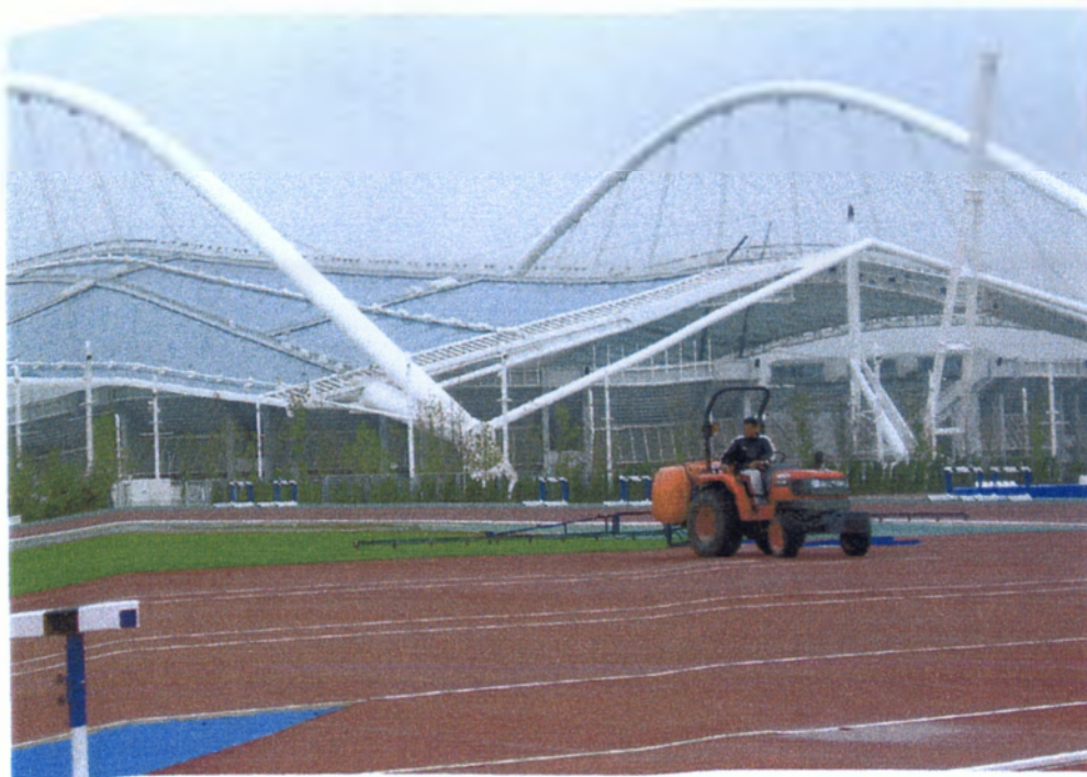
Εικόνα 5. Το Στέγαστρο του Ολυμπιακού Σταδίου στην τελική του μορφή.
