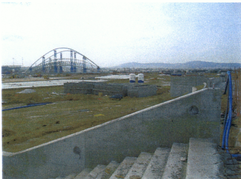
Εικόνα 4. Άποψη εργοταξίου από περιοχή γηπέδων.
