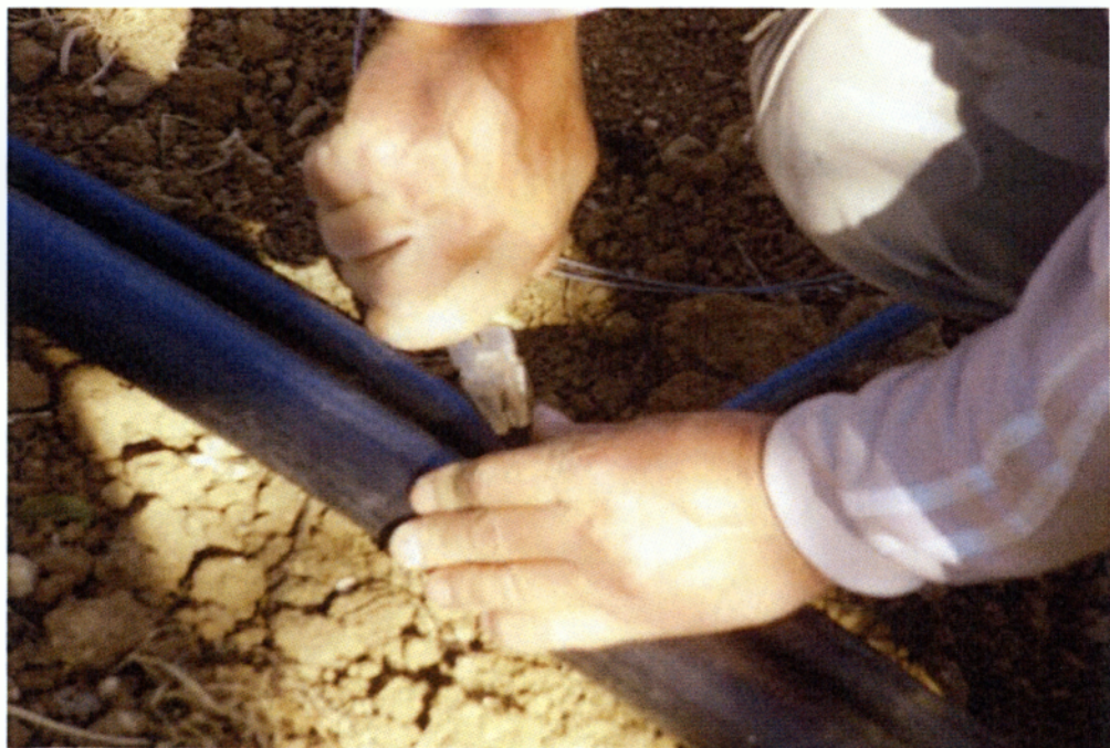
Εικόνα 2. 3 : Συνδεσμολογία με τον κεντρικό αγωγό
