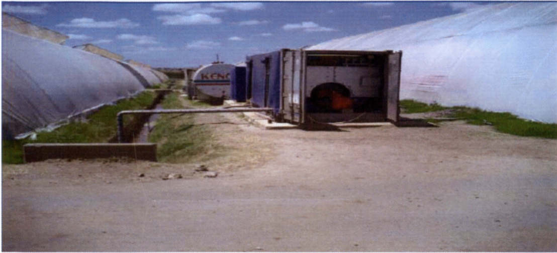
Εικόνα 3.4 Εγκατάσταση λέβητα ατμοπολύμανσης
