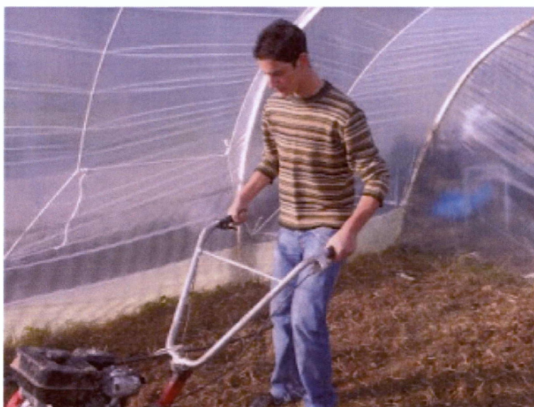
Εικόνα 11. Κατεργασία εδάφους για την εγκατάσταση της φυτείας.
