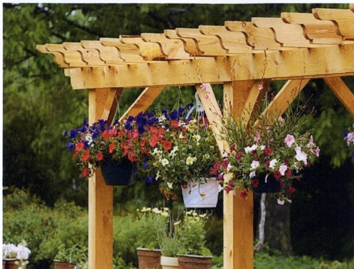
Εικόνα 7: "Κατασκευή ξύλινης πέργκολας με σουηδικό ξύλο, τελείωμα με διακοσμητικά φουρούσια, περασμένο με βερνίκι εμποτισμού στο φυσικό του χρώμα. Παρέχουν σκιά και προστασία από την βροχή."
