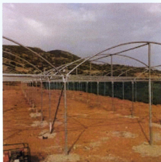
Εικόνα 3.2-Κατασκευή του μεταλλικού σκελετού
