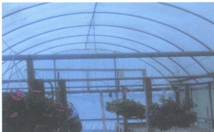
Εικ. 3: Μεταλλικό θερμοκήπιο από γαλβανισμένο χάλυβα. (Προσωπικό αρχείο)
