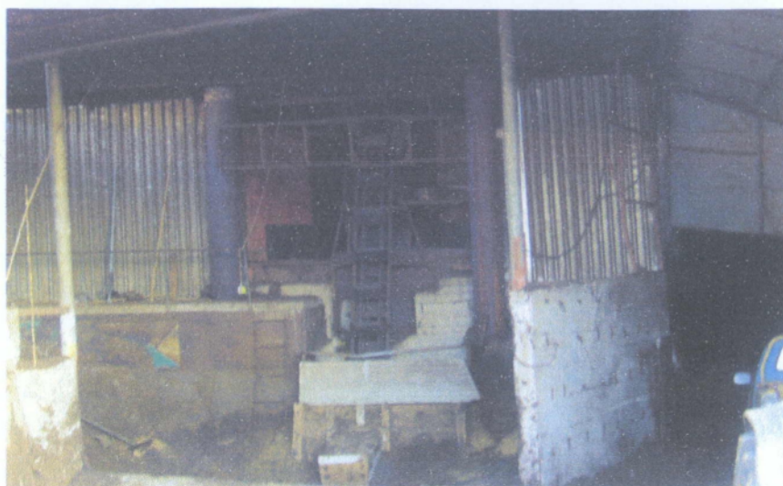
Εικ.10: Κεντρικό σύστημα θέρμανσης με καύση πυρηνόξυλο (Προσωπικό αρχείο)
