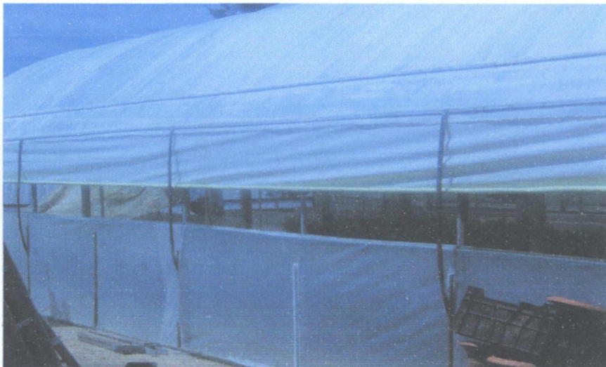
Εικ. 5: Θερμοκήπιο με υλικό κάλυψης Νάilon Κρήτης. (Προσωπικό αρχείο)
