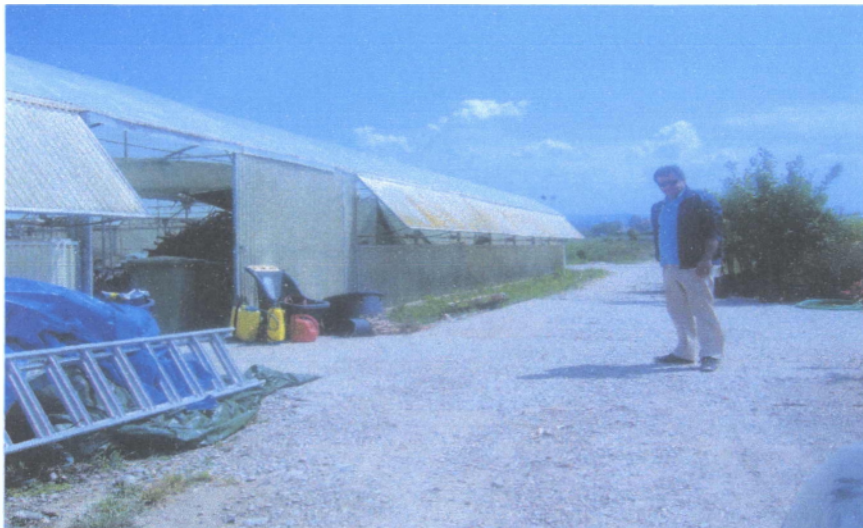
Εικ. 4: Θερμοκήπιο με υλικό πλαγιοκάλυψης πολυαιθυλένιο (Προσωπικό αρχείο)
