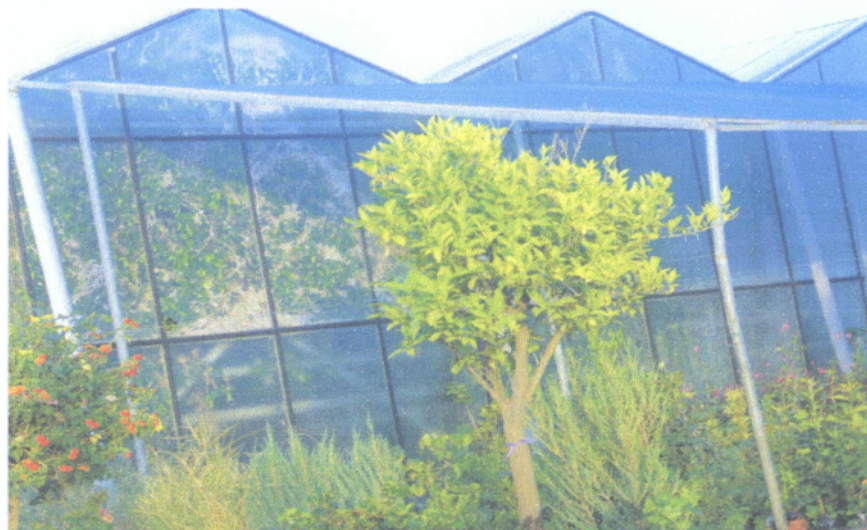
Εικ. 2: Γυάλινο θερμοκήπιο αμφικλίνες, υψηλής οροφής, πολλαπλής γραμμής.
