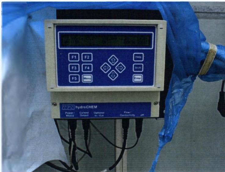
Εικόνα 3: Κεφαλή συστήματος επίπλευσης
