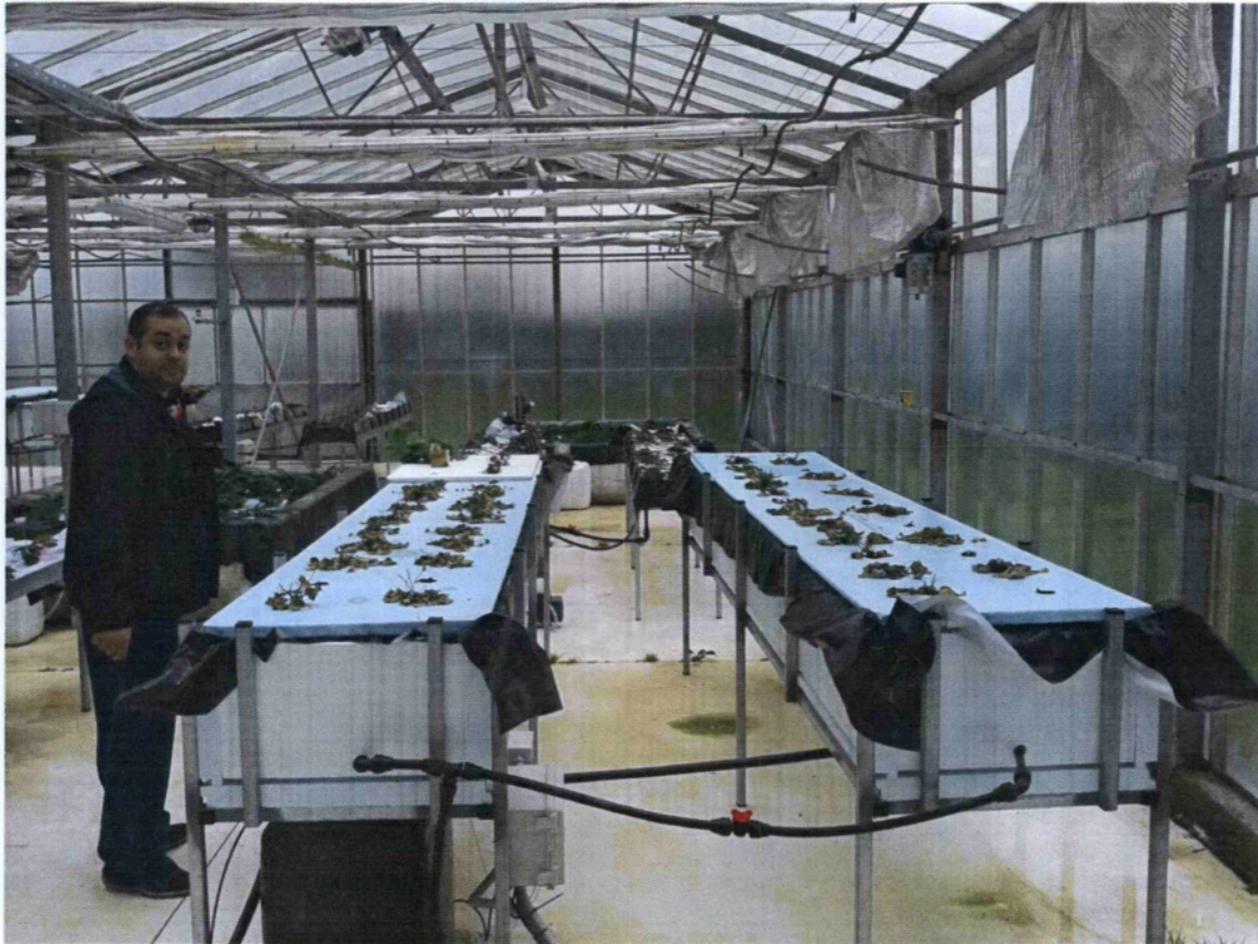
Εικ..5.7α: Βλάβη στο αρδευτικό σύστημα την αεροπονία
