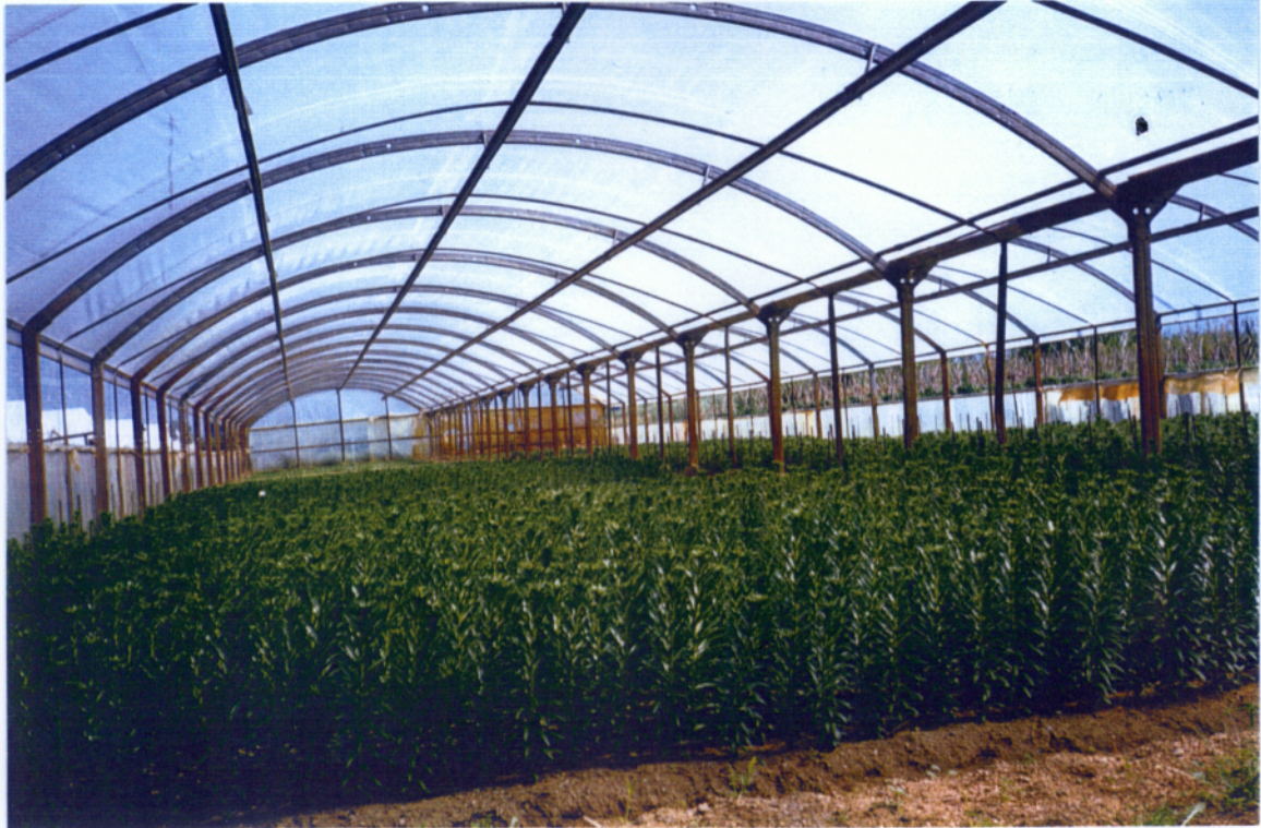
Εικ. 1. Θερμοκήπιο ανθοκομικών κατασκευασμένο από το Μεσσηνιακό Μεταλλουργείο – Νίκος Γκλεγκλές.
