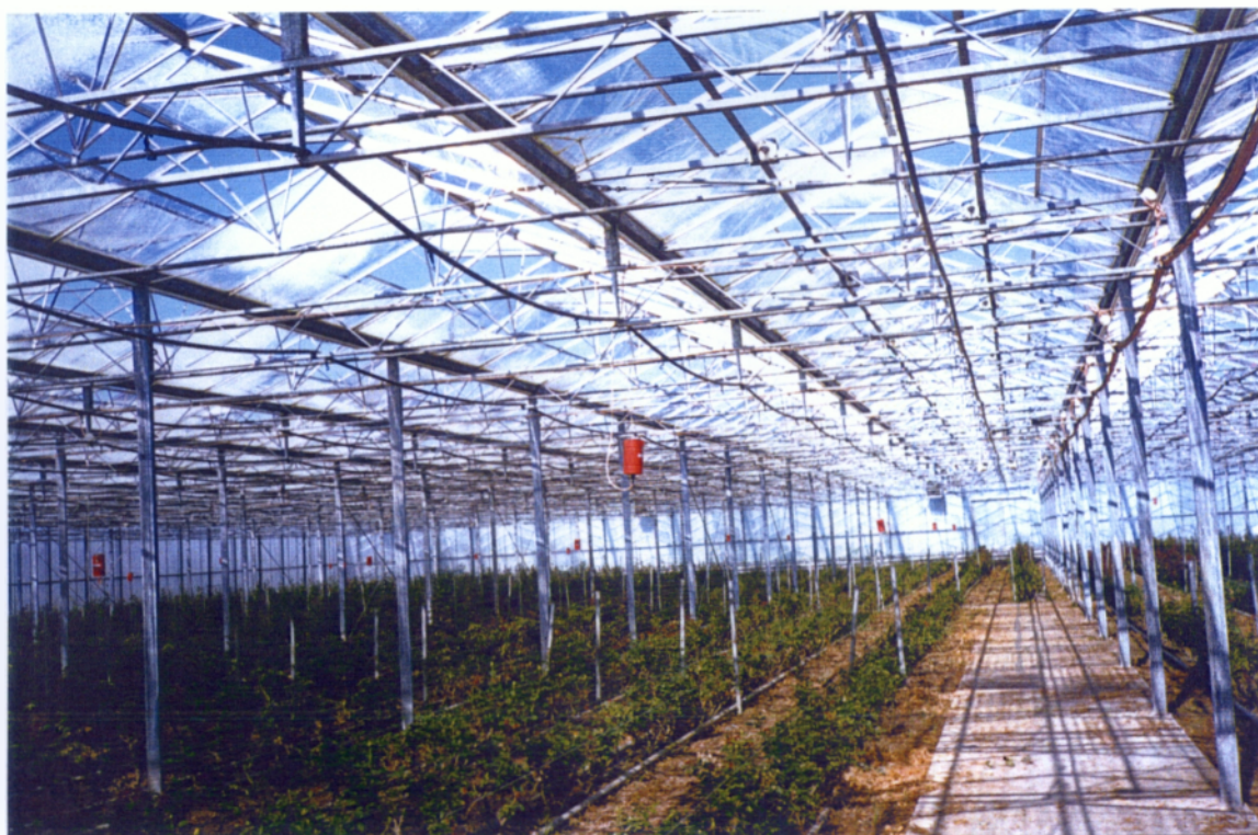
Εικ. 3 : Υαλόφρακτο, αμφίρρικτο διπλής κορυφής θερμοκήπιο παραγωγής τριανταφύλλων (Ασπρόχωμα)
