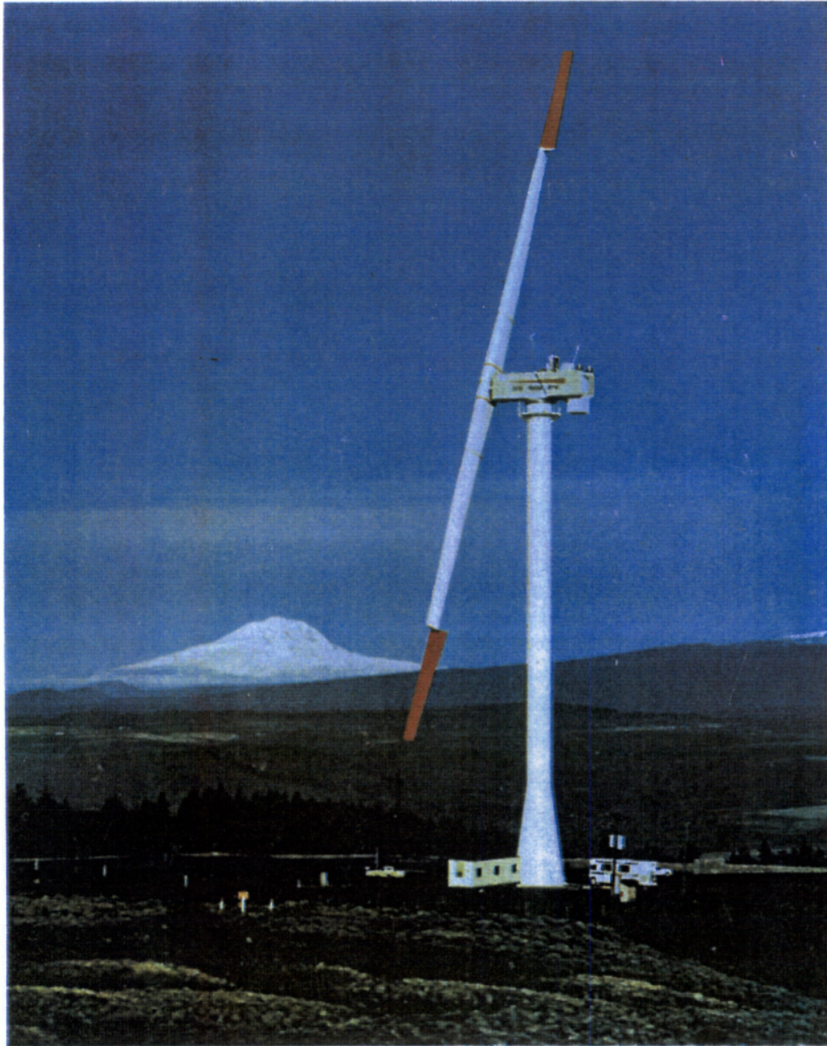
Φωτογραφία 2 DOE/NASA 2500kW Πειραματικός Α/Κ Goodnoe Hillis, Washington.
