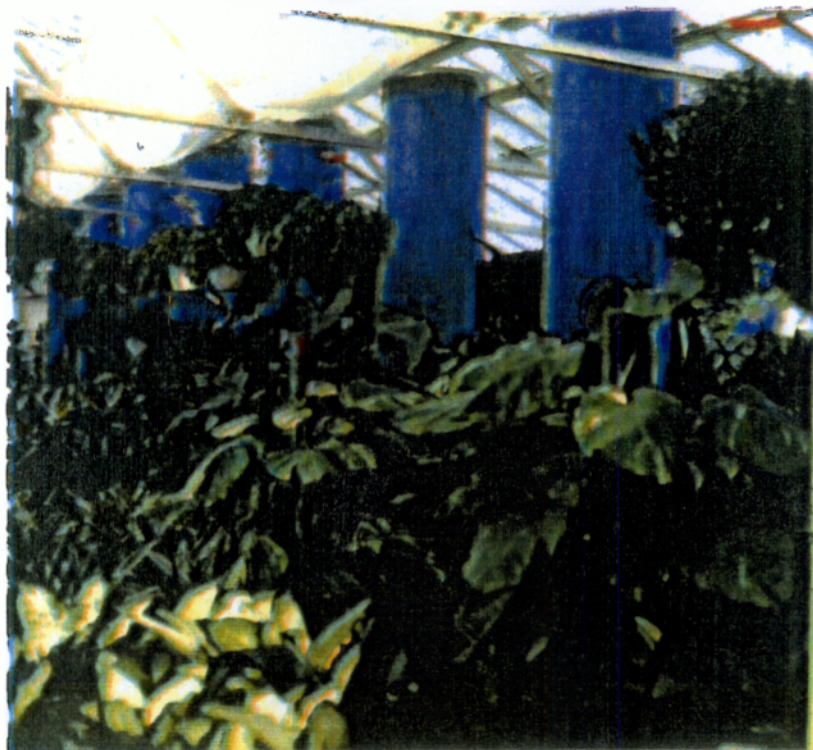
Εικ 6. Σωλήνες πολυαιθυλενίου γεμάτοι νερό για παθητική συλλογή και απόδοση της ηλιακής ενέργειας.
