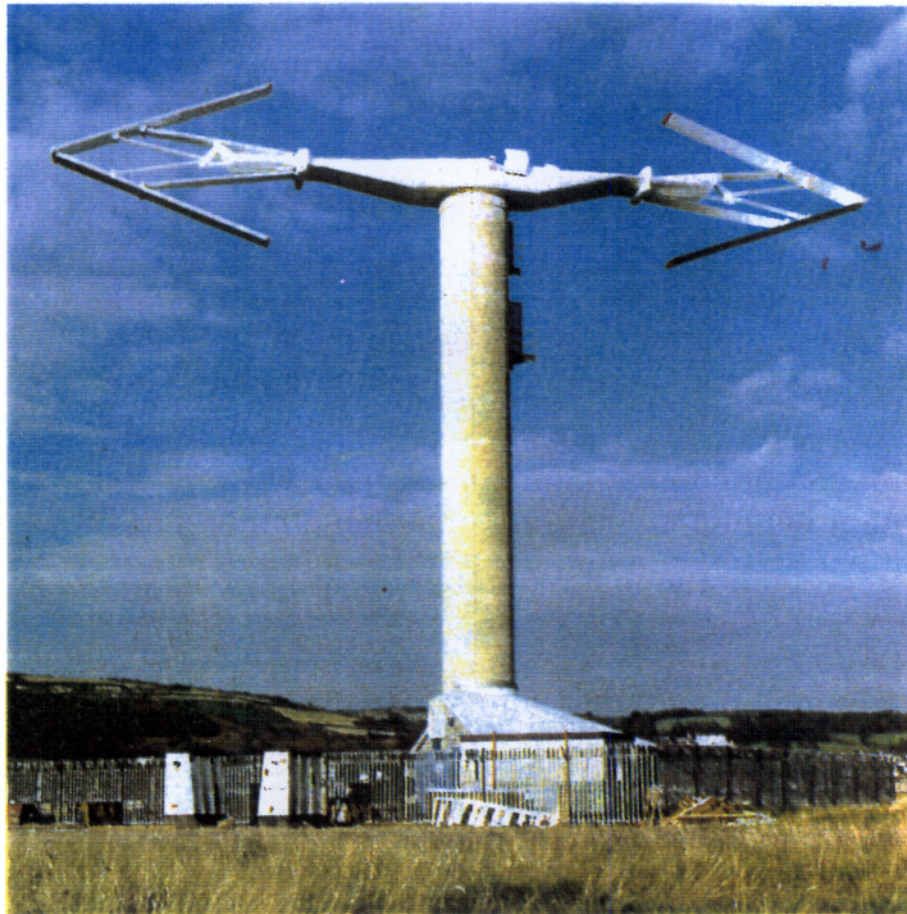
Φωτογραφία 4 Ανεμογεννήτρια κατακόρυφου άξονα, μεταβλητού σχήματος πτερών, διαμέτρου 25m.
