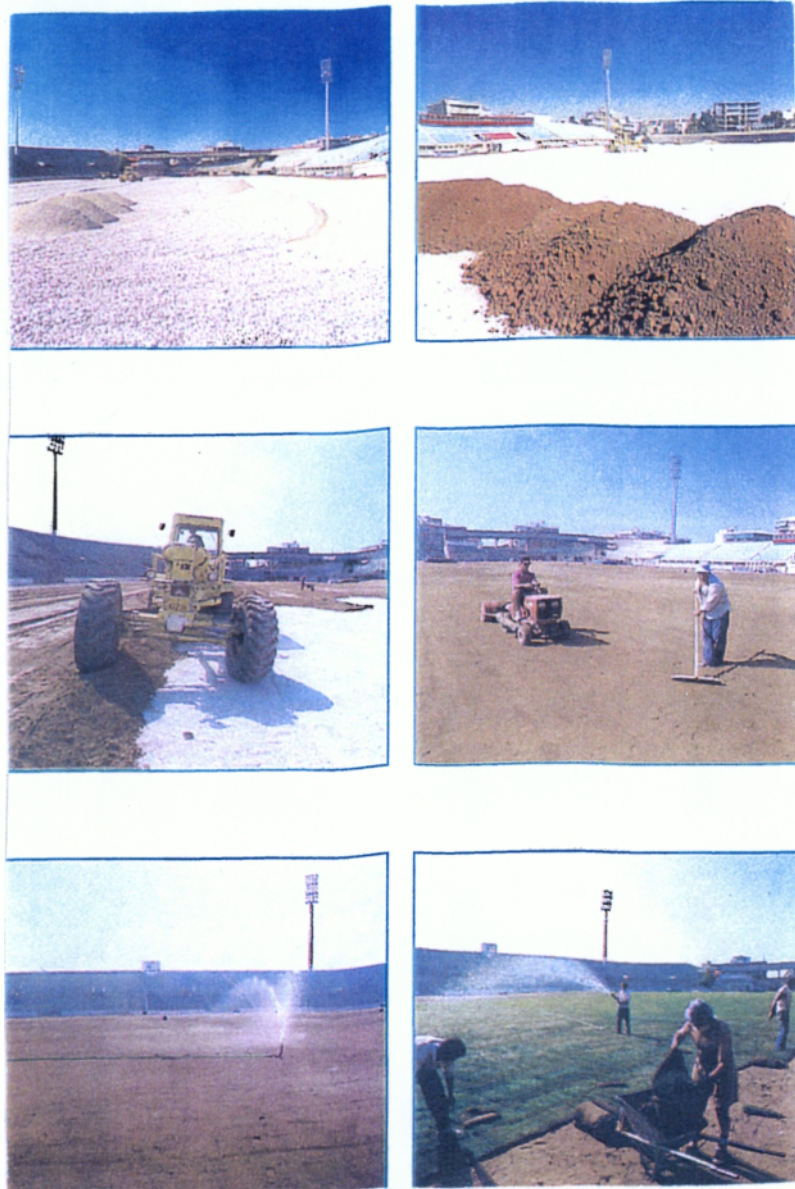
Σχήμα 19: Τοποθέτηση του έτοιμου γκαζόν (Μπούκας)
