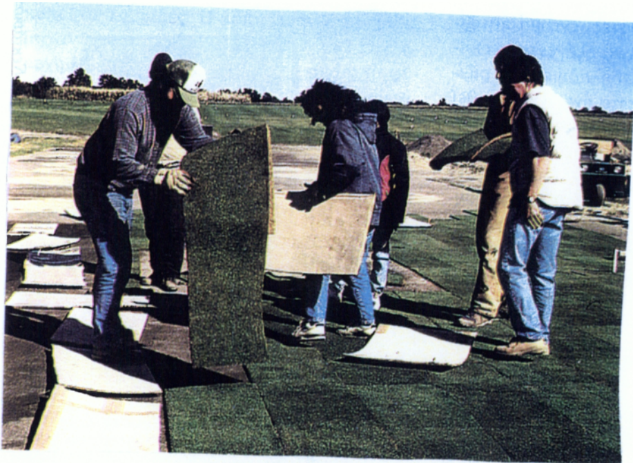
Σχήμα 18: Τοποθέτηση έτοιμου χλοοτάπητα (Νεκτάριος, 2000)
