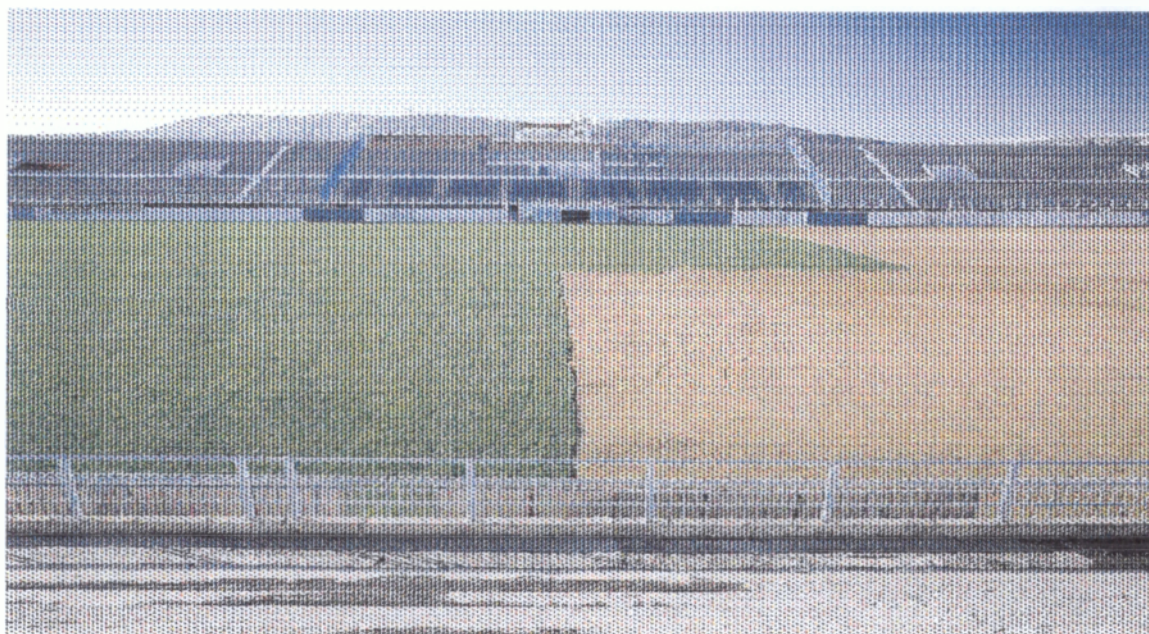
Εικόνα 12β : Πανοραμική άποψη μισοτελειωμένου γηπέδου το οποίο στρώθηκε με τη βοήθεια μηχανημάτων (Ρέβελος )
