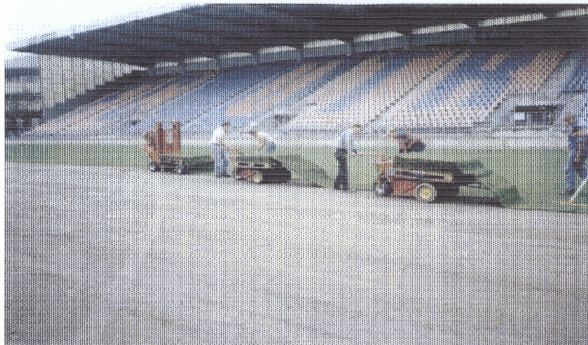
Εικόνα 12α : Εγκατάσταση έτοιμου χλοοτάπητα με τη βοήθεια μηχανημάτων
