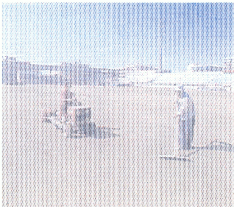
Εικόνα 8: Ισοπέδωση μίγματος εδάφους
