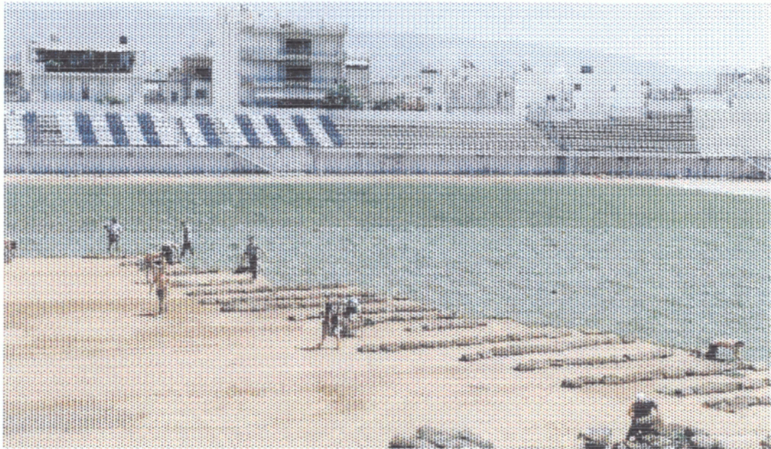
Εικόνα 10 : Εγκατάσταση έτοιμου χλοοτάπητα (Ρέβελος )
