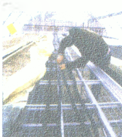
Προετοιμασία θερμοσπορείου. Η θέρμανση θα γίνεται με ζεστό νερό που θα κυκλοφορεί στους σωλήνες κάτω από το έδαφος.
