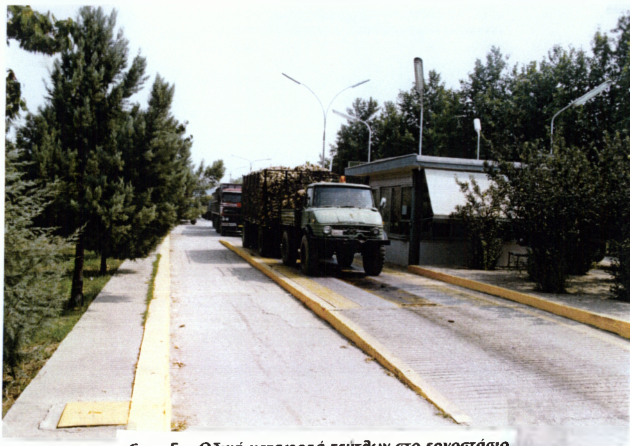
Εικ. 5. Οδική μεταφορά τεύτλων στο εργοστάσιο
