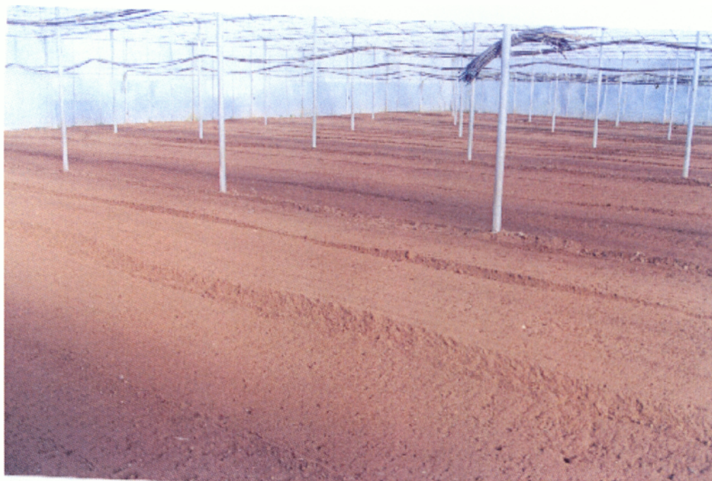
Φώτο4 Προετοιμασία του χώρου σποράς
