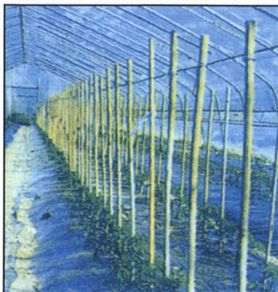
Εικόνα 1.5: Για την κάλυψη του θερμοκηπίου χρησιμοποιούνται πλαστικά φύλλα από EVA ή PE
