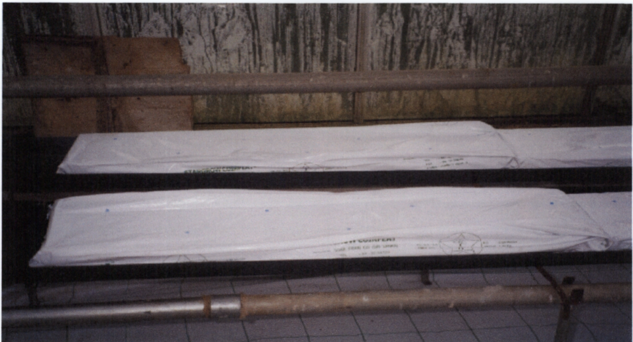
Εγκατάσταση των slabs (πλάκες) κοκκοφοίνικα
