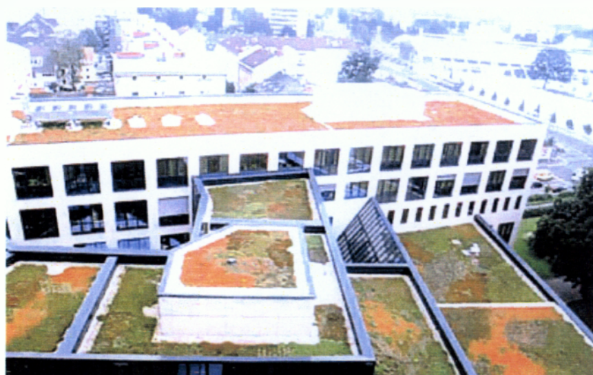
Εικόνα 29 Ταρατσόκηπος σε χαμηλό προφίλ: Φαίνονται περιμετρικές λεπτομέρειες Πηγή: Διαδίκτυο 2
