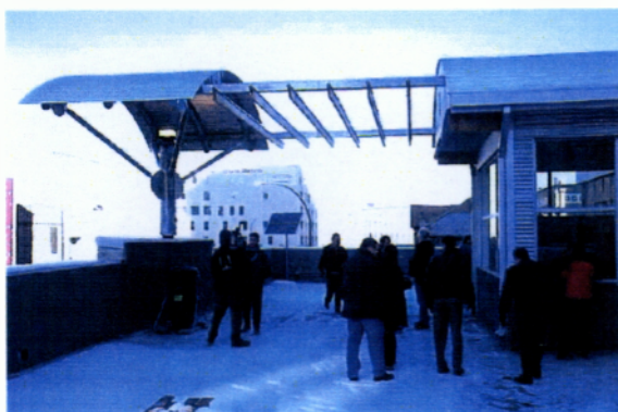
Εικόνα 33 Ταρατσόκηπος πάνω από το Mountain Equipment Co-op. Το ηλιακό σκίαστρο στην άκρη του κήπου δίνει ενέργεια σε ένα σύστημα άρδευσης. Πηγή: Διαδίκτυο 13
