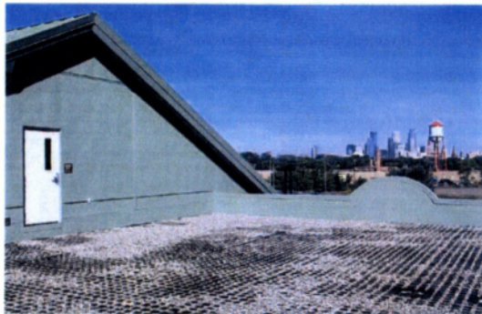
Εικόνα 35 Ο μισοτελειωμένος ταρατσόκηπος στο επιχειρησιακό κέντρο Phillips με στρώμα χώματος παχύ 9 ίντσες. Πηγή: Διαδίκτυο 13
