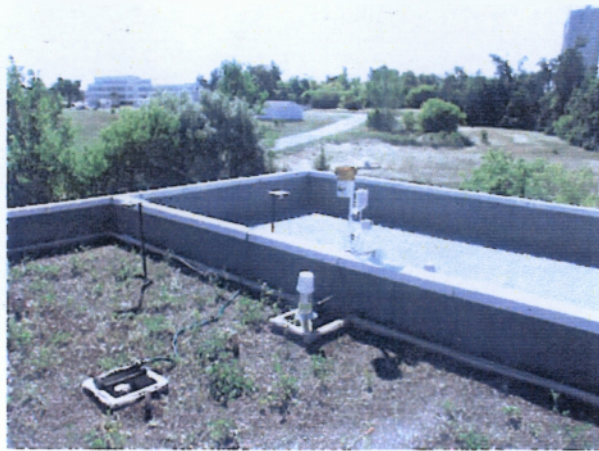
Εικόνα 15 Στέγη των IRC ερευνητών λίγο μετά την κατασκευή. Το παραπέτασμα χωρίζει στα δύο την οροφή, εκεί όπου έχουν τοποθετηθεί οι μετεωρολογικοί σταθμοί. Πηγή: Διαδίκτυο 3.
