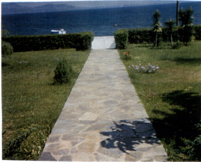
Εικ. 1.21: Μονοπάτι κατασκευασμένο από πέτρες Καρύστου.
