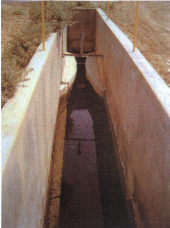
Εικόνα 1.4. Διώρυγα Parshall με αισθητήριο στάθμης για μέτρηση παροχής.
