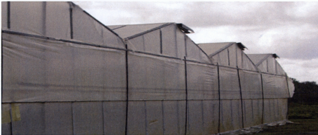
Εικόνα 1. Η εξωτερική εικόνα του θερμοκηπίου. Διακρίνεται το υλικό κάλυψης και τα μισάνοιχτα παράθρα της οροφής.
