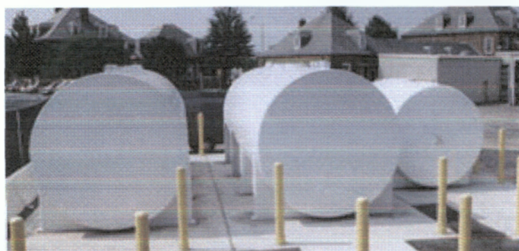
Εικόνα 11: Δεξαμενές θρεπτικών διαλυμάτων
