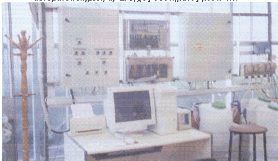
ΕΙΚΟΝΑ 17 Κεφαλή δικτύου άρδευσης και λίπανσης πλήρως αυτοματοποιημένη α) Έλεγχος συστήματος μέσω Υ/Η
