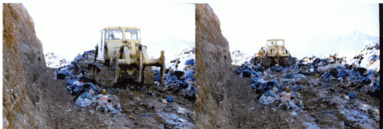
Εικόνα 9-4: Διάστροση αποβλήτων από τον προωθητή
