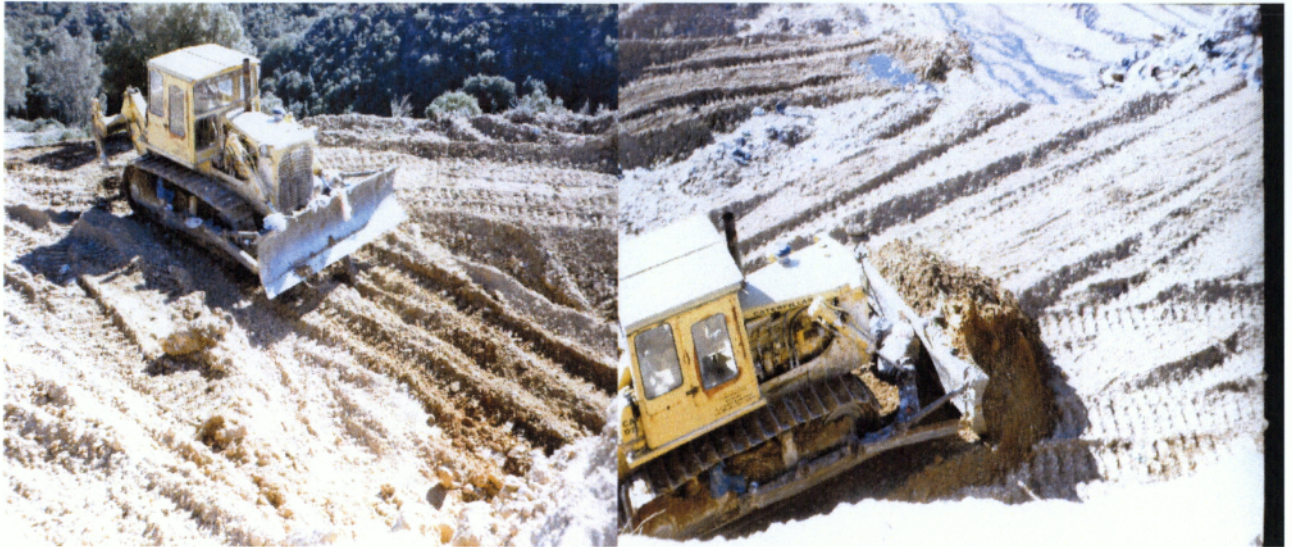
Εικόνα 9-7: Επικάλυψη αποβλήτων με χώμα
