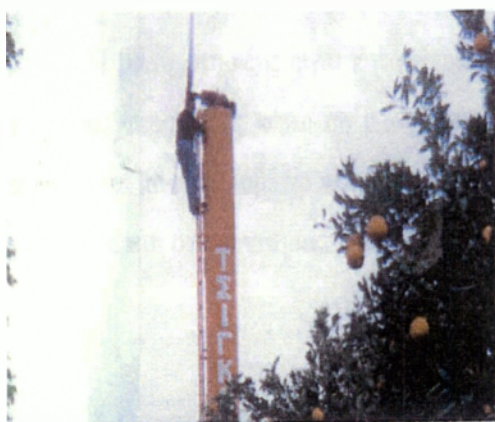
ΕΙΚ. 2.18 Ετήσια συντήρηση γωνιακής ανεμομείκτης.
