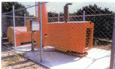
ΕΙΚ.2.30 Κιγκλίδωμα προστασίας ανεμομεικτη.
