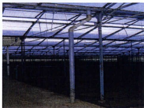
Εικόνα 26. Τρόπος απομάκρυνσης του πλεονάζον ύδατος στο θερμοκήπιο της εκμετάλλευσης.
