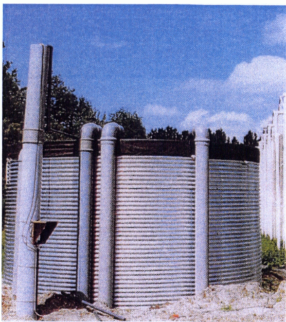
Εικόνα 28. Μεταλλική δεξαμενή νερού από γεώτρηση.
