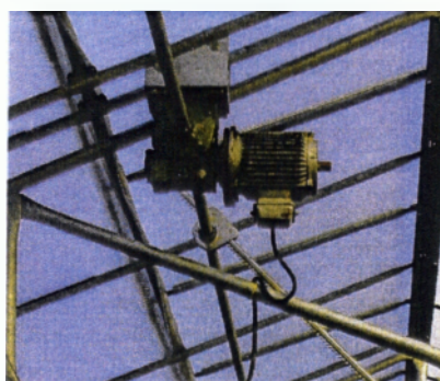
Εικόνα 27. Ηλεκτροκινητήρας για αυτόματο άνοιγμα των παραθύρων στο θερμοκήπιο της επιχείρησης
