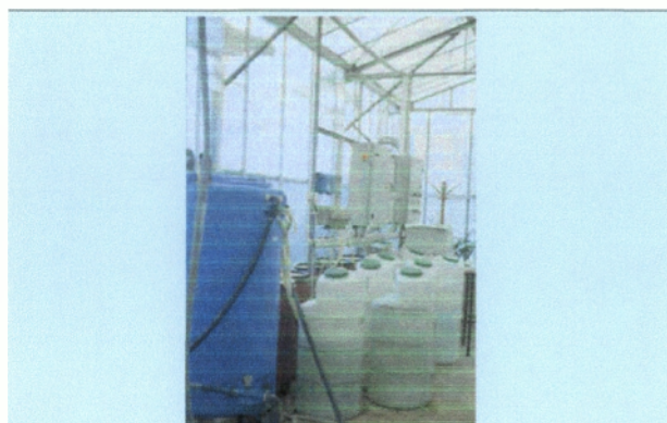
Εικόνα 3.5.β. Κεφαλή δικτύου άρδευσης και λίπανσης πλήρως αυτοματοποιημένη: β) Δοχεία υγρών λιπασμάτων και αυτόματο σύστημα έγχυσης τους στο νερό άρδευσης.
