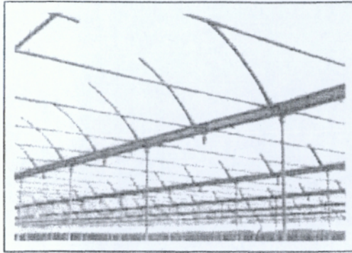
Σχήμα 18. Διάτρητος σωλήνας από πολυαιθυλένιο που χρησιμοποιείται για να βελτιώνει τη διανομή του αέρα.
