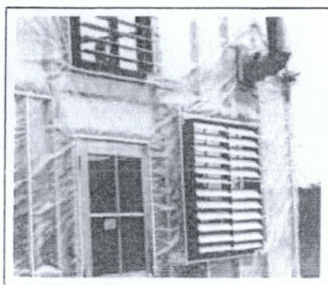
Σχήμα 42. Παράθυρο με γρίλιες για τον εξαερισμό του ανεμιστήρα.
