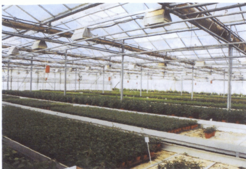
Σχήμα 63. Στην οροφή διακρίνεται ο εξοπλισμός τεχνητού φωτισμού, για αύξηση της παραγωγής της φωτοσύνθεσης.
