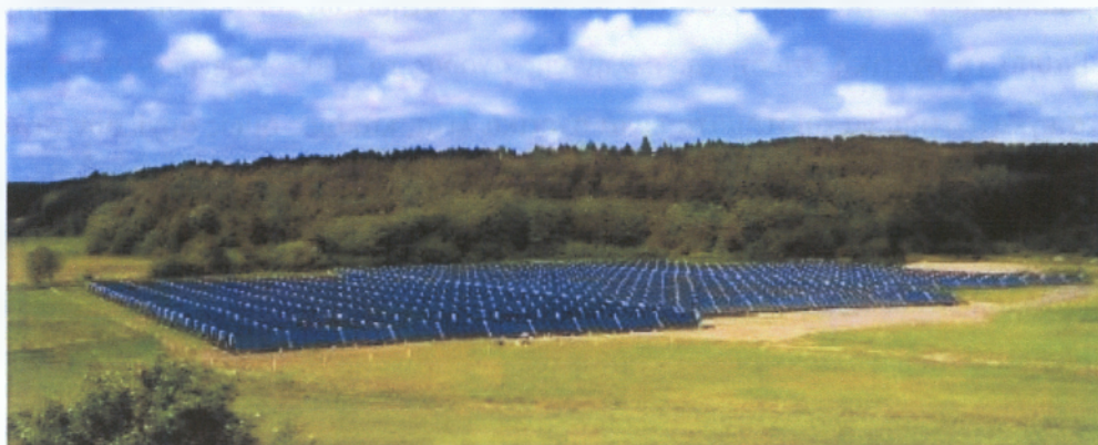
Ηλιοθερμικό σύστημα για τηλεθέρμανση στη Σουηδία
