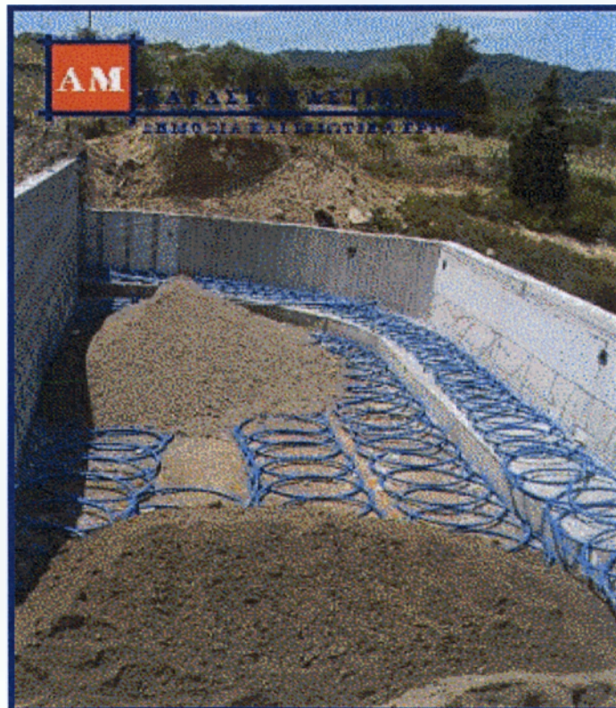
Εικ.8 Εγκατάσταση σωλήνων για γεωθερμική εκμετάλλευση
