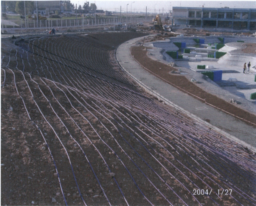
Εικόνα 122 Υπόγεια άρδευση Κανόε-Σλάλομ (Πριν)
