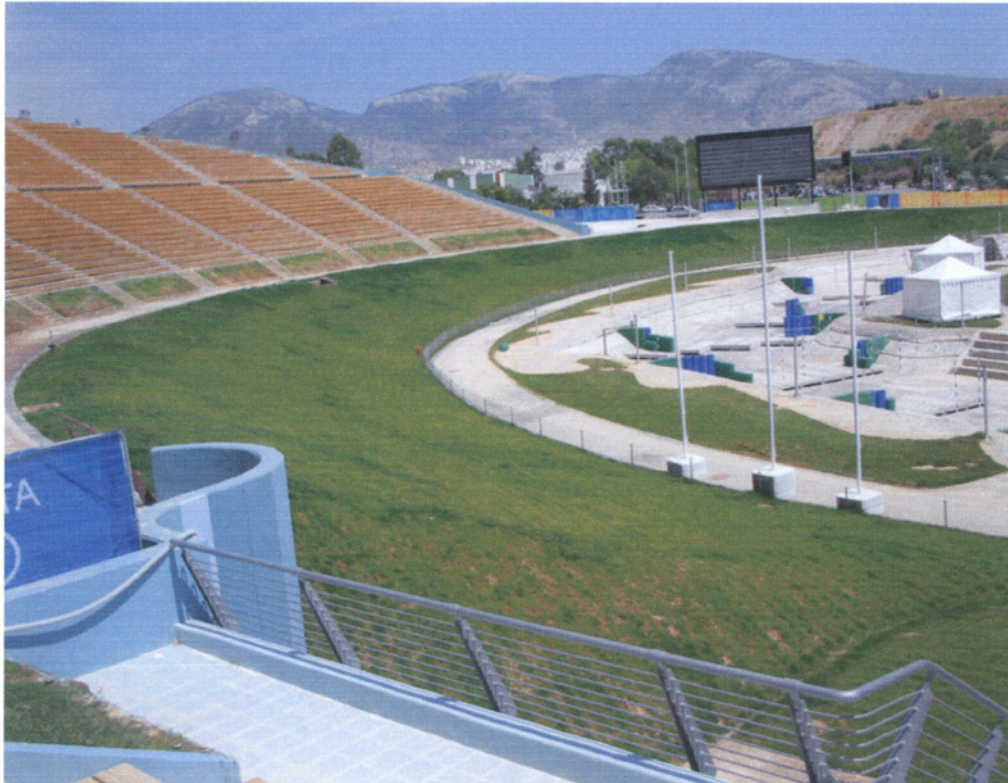
Εικόνα 123 Υπόγεια άρδευση Κανόε-Σλάλομ (Μετά)
