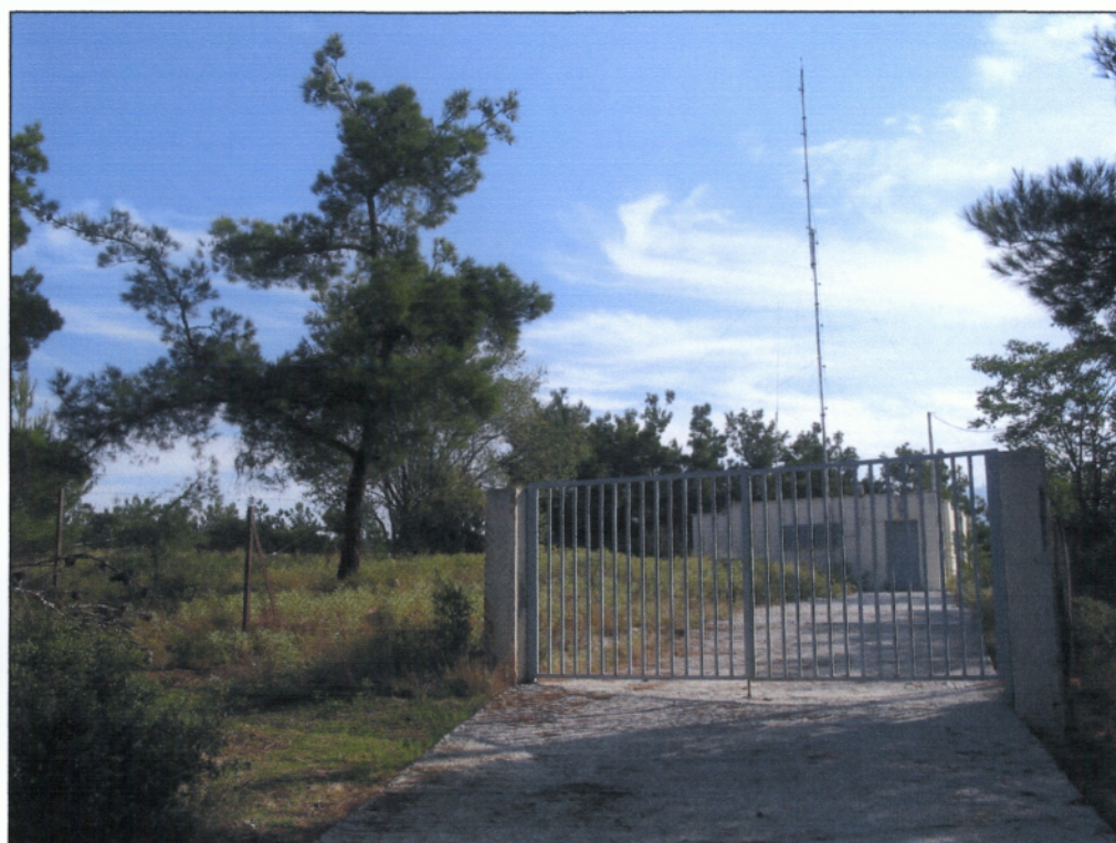
Φωτ 13. Δεξαμενή ύδρευσης.
