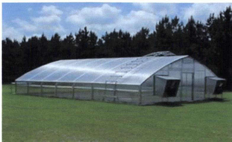
Εικόνα 11.Εκσυγχρονισμένη θερμοκηπιακή εγκατάσταση
