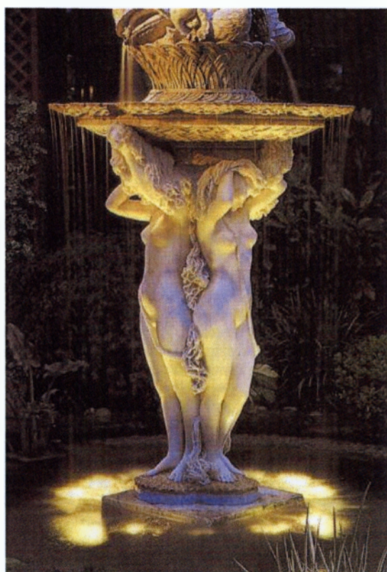
Εικ.36. Υποβρύχιος φωτισμός συντριβανιού με προβολείς τοποθετημένους στην είσοδο της πτώσης του νερού (τουλάχιστον 5 cm κάτω από την επιφάνεια του νερού), έτσι ώστε να αποκρύπτετε μέσα στην φωτεινότητα των παφλασμών του νερού, ενώ η δέσμη του φωτός δημιουργεί πρισματικά οπτικά μοτίβα φωτισμού.
