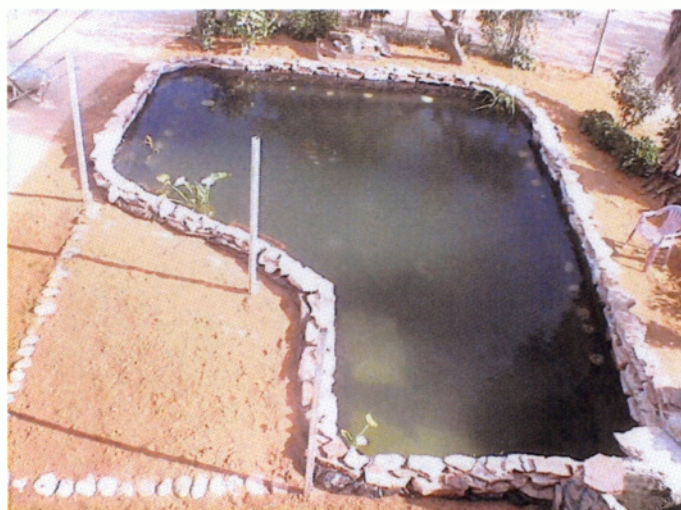
Εικ.32. Γεμίζουμε με νερό και σκεπάζουμε το πλαστικό με πέτρες για να μην φαίνεται.
