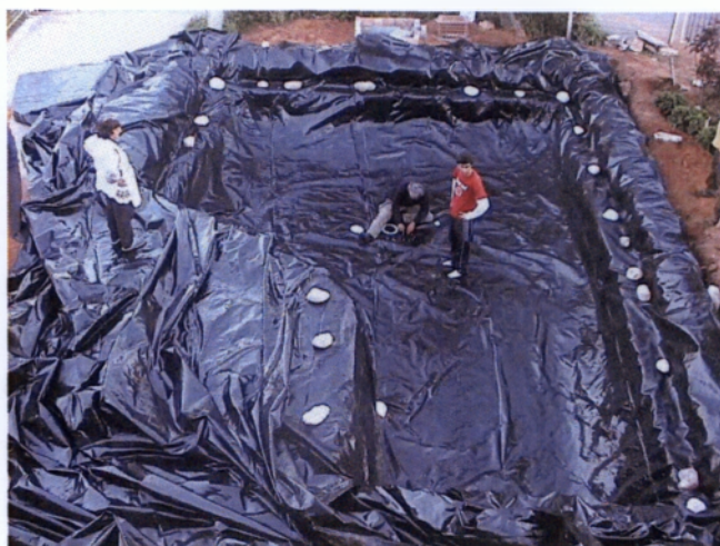
Εικ.30,31. Το σκάψιμο για την δημιουργία λίμνης περίπου 70.000 λίτρων από τον Φώτη Γεωργακόπουλο στην Καλαμάτα της Μεσσηνίας. Στρώνισιμο εύκαμπτου πλαστικού και ύστερα το κόψιμο του για να είμαστε ακριβείς.
