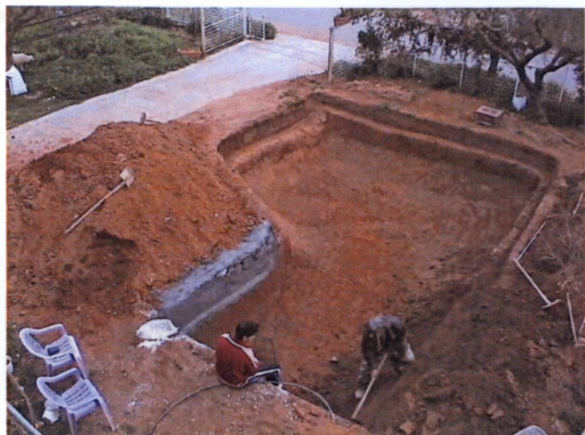
Εικ.30,31. Το σκάψιμο για την δημιουργία λίμνης περίπου 70.000 λίτρων από τον Φώτη Γεωργακόπουλο στην Καλαμάτα της Μεσσηνίας. Στρώνισιμο εύκαμπτου πλαστικού και ύστερα το κόψιμο του για να είμαστε ακριβείς.
