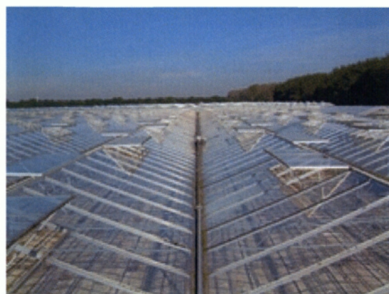
Εικόνα 2.11. Σκελετός θερμοκηπίου για υποστήριξη υαλοπίνακα και δεξιά θερμοκήπιο με κάλυψη από γυαλί.
