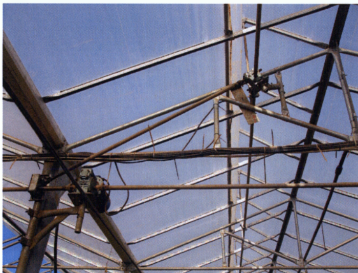
Εικόνα 2.2. Βασική κατασκευαστική μονάδα μεταλλικού θερμοκηπίου .
