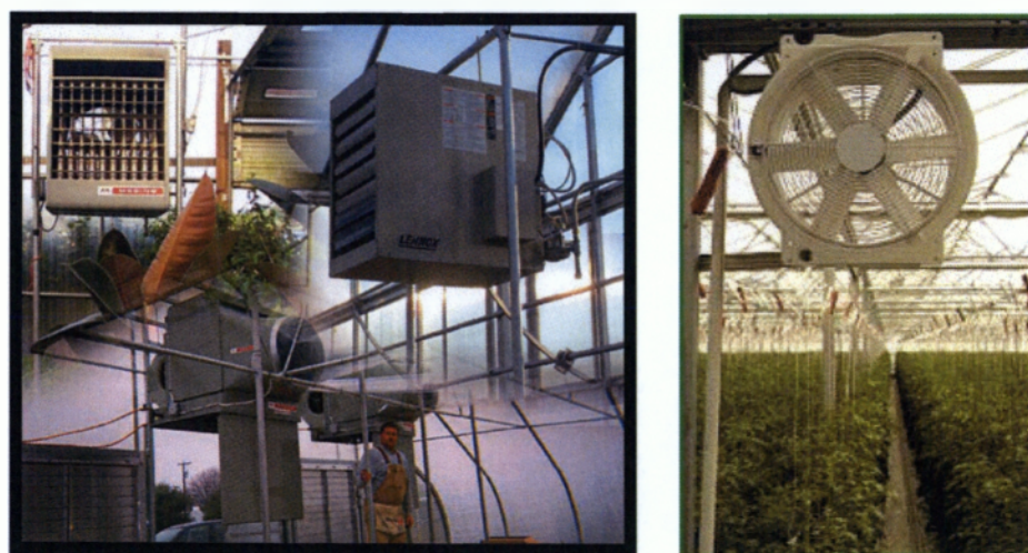
Εικόνα 5.9. Διάφορα συστήματα δυναμικού αερισμού.
