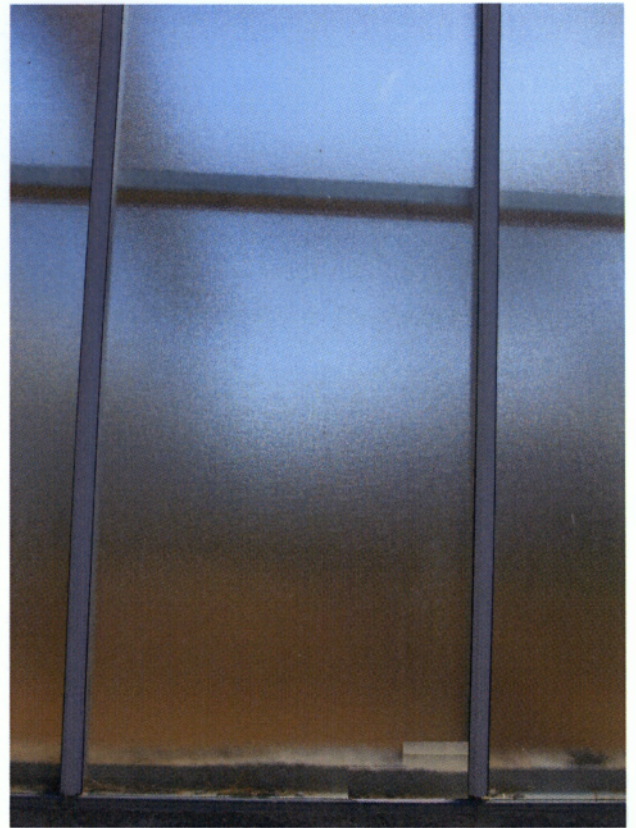
Εικόνα 2.13. Κάλυψη θερμοκηπίου με γυαλί.
