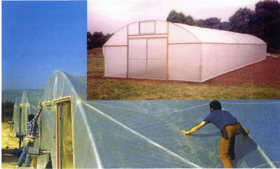
Εικόνα 2.8. Κάλυψη θερμοκηπίου με φύλλο πολυαιθυλενίου.
