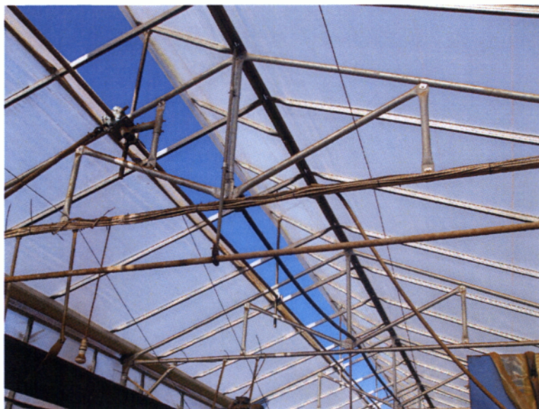
Εικόνα 2.6. Φυσικός αερισμός με παράθυρα οροφής
