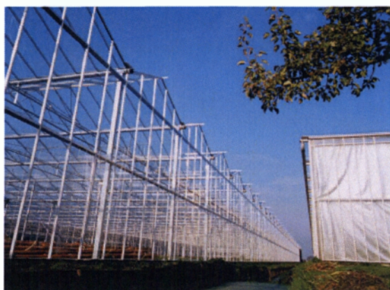
Εικόνα 2.11. Σκελετός θερμοκηπίου για υποστήριξη υαλοπίνακα και δεξιά θερμοκήπιο με κάλυψη από γυαλί.
