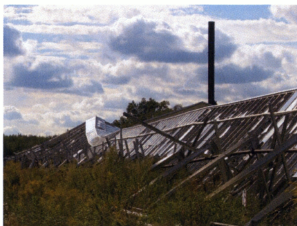
Εικόνα 2.12. Καταστροφή γυάλινου θερμοκηπίου από ανεμοθύελλα.
