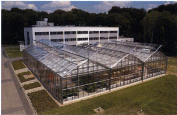
Εικόνα 2.13. Κάλυψη θερμοκηπίου με γυαλί.
