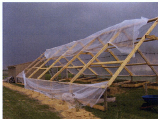
Εικόνα 3.5. Δημιουργία ανεμοθραύστη και δεξιά καταστροφή θερμοκηπίου από πίεση ανέμου.
