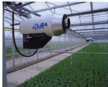
Εικόνα 4.2. Εμπλουτισμός θερμοκηπίου με CO 2 .
