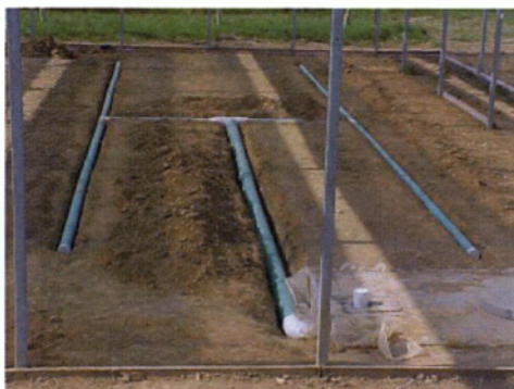
Εικόνα 3.4. Διάταξη στράγγισης στο θερμοκήπιο.
