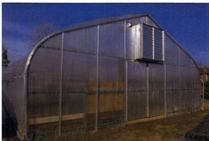
Εικόνα 2.10. Κατασκευή θερμοκηπίου με φύλλα fiberglass.
