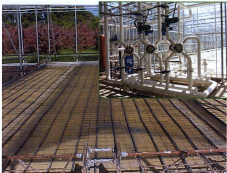
Εικόνα 5.2. Κεντρικό σύστημα θέρμανσης με σωληνώσεις στο δάπεδο.
