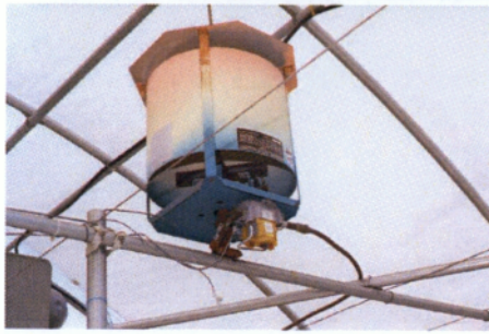
Εικόνα 4.2. Εμπλουτισμός θερμοκηπίου με CO 2 .
