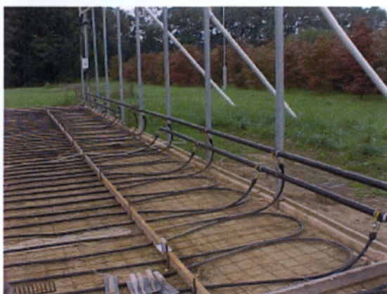
Εικόνα 5.6. Εύκαμπτους σωλήνες διανομής από πλαστικά υλικά με της βαλβίδες διανομής δεξιά.
