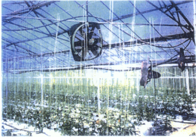
Εικ. 1.6: Τρόπος ανάδευσης του αέρα στο θερμοκήπιο.
