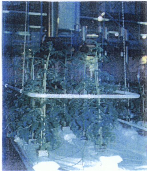
Εικ. 3.2: Σωλήνας θέρμανσης μετακινούμενος κατακόρυφα.
