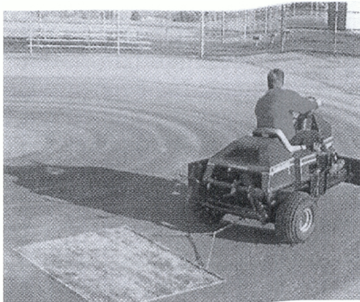
Εκόνα 8: Ισοπέδωση μίγματος εδάφους
