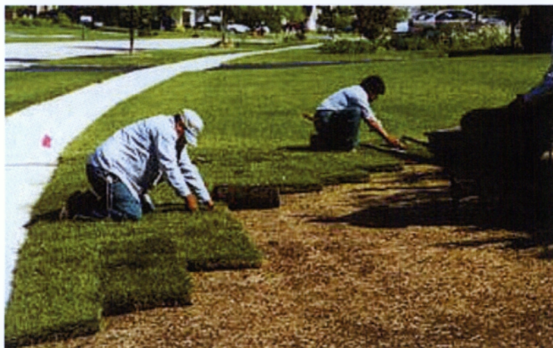
Εικόνα 129 Τοποθέτηση έτοιμου χλοοτάπητα
